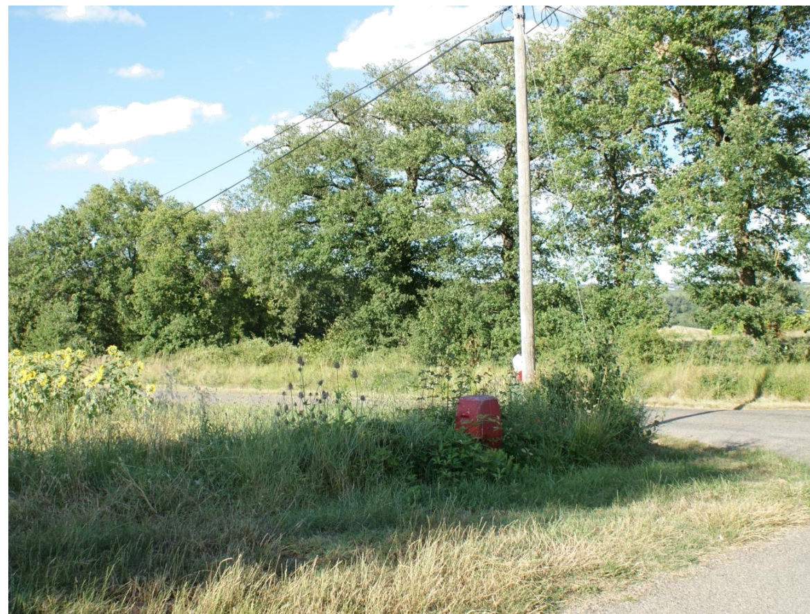
Vue sur poteau d'incendie, au niveau du lieu-dit LA TOUR, sur la RD 205.
