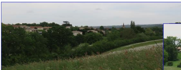
Route de Saint Soulan ; secteur en construction en vis à vis des quartiers hauts anciens de Samatan
