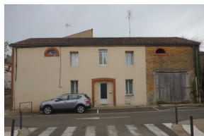
Rénovation d'un logement Rue de la Poste
