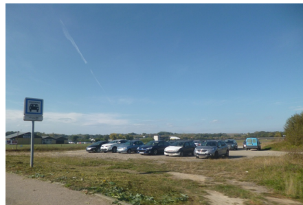
Aire de covoiturage en marge de l'avenue de Daniatte et de la plate-forme de courrier.
