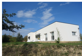
Construction neuve Route de Laujuzan
