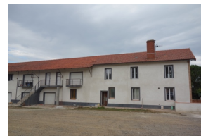
Réhabilitation d'un bâtiment d'activité Avenue des Pyrénées
