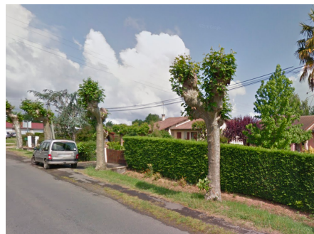
Bordure piétonne à prolonger entre le centre-ville et le site Couso Héphaïstos en marge de l'Avenue du Cassou de Herré (RD 143).
