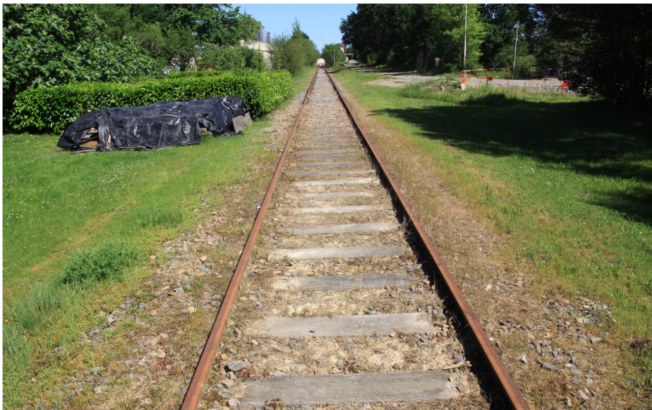
Figure 4 : La zone expertisée, vue depuis la limite Sud, vers le Nord
