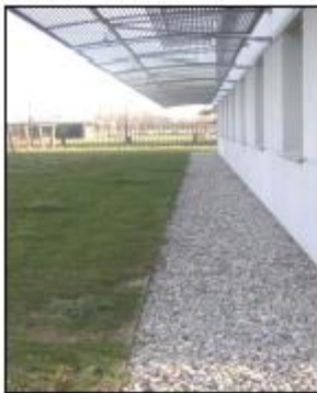
▶ Tranchées sous toit
