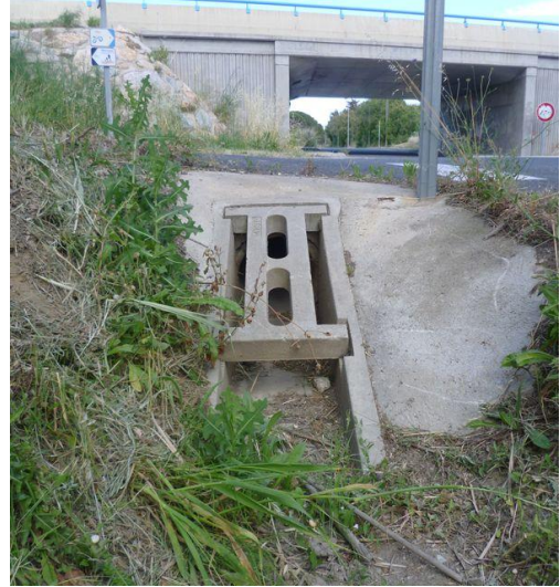
Buse de franchissement avec tête d'aqueduc
