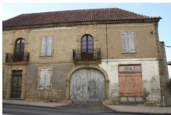
Ouvertures ordonnancées sur la façade, porche important Source : L'Artifex 2015
