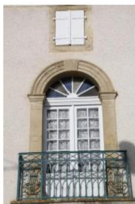
Détails d'ouvrages en calcaire intégrés aux bâtisses Source : L'Artifex 2015
