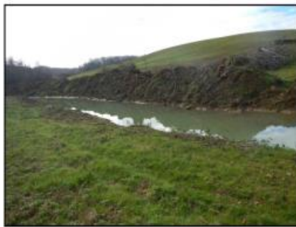
Ruisseau de la Bassoue : berge dégradées Source : L'Artifex 2015
