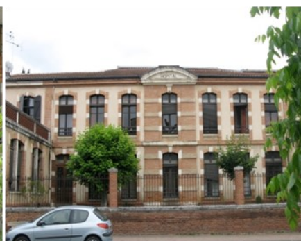
Façade de l'hôpital, Boulevard des Pyrénées.
