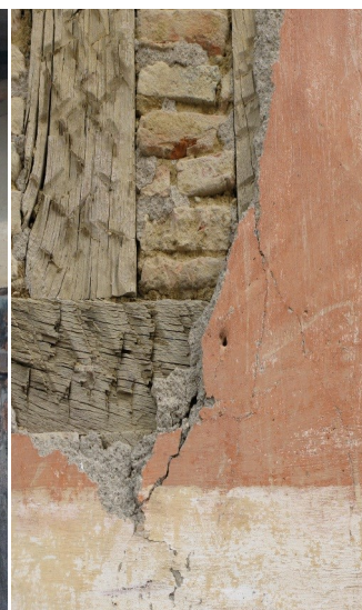
Détails d'un enduit sur briques et des éclisses dans un torchis.
