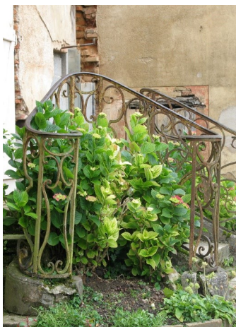
Détail perron et garde corps.
