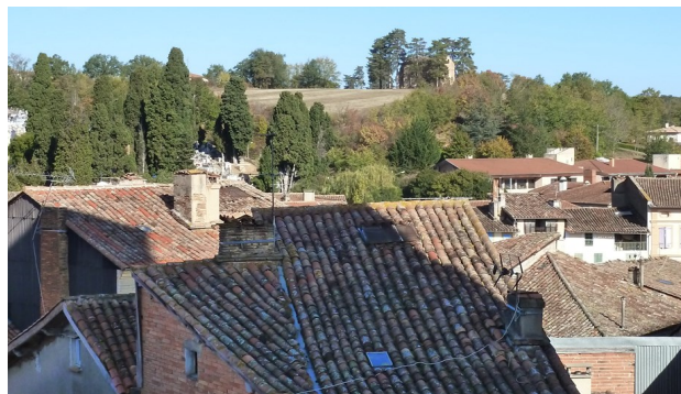
Point de vue n°1 : Saint-Majan vue du clocher de la cathédrale : les toits, les cyprès du cimetière, boisements et prairies sur les coteaux, la chapelle, les grands arbres.
