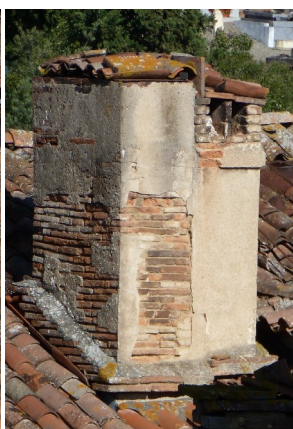
Les tuiles canal et leur assemblage, le bardage de la lucarne, les cheminées avec leur souche et leur mitre.
