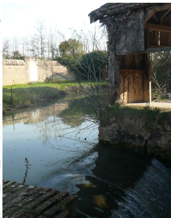
Les jardins et leur clôture sur la Save, les berges, les ouvrages.
