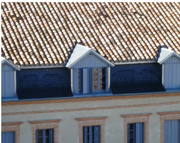
Cas exceptionnel à Lombez de toit à la Mansart. Ardoises sur le rampant visible de la rue et tuiles canal sur le couvrant. Lucarnes « jacobines » intégrées dans le rampant.
