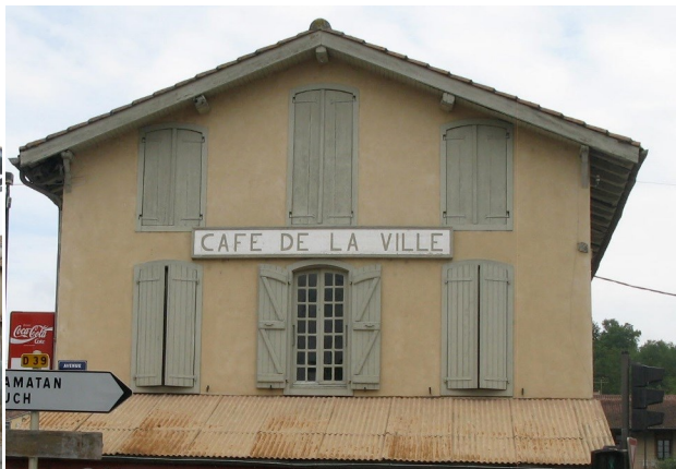
1, route de Samatan. Pans de bois et brique totalement enduit. L'enduit ne couvre pas les encadrements peints.
