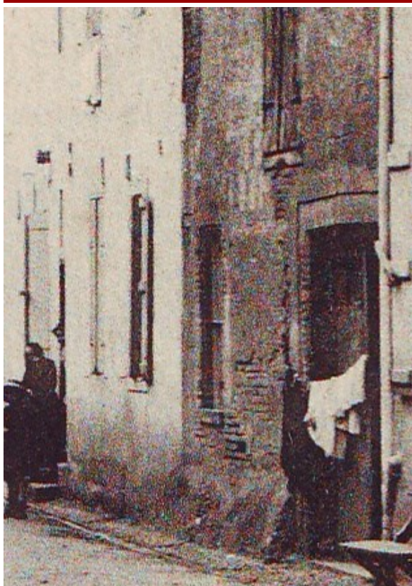
Début XX e : enduit déstructuré, remontées capillaires et briques dégradées. Coll. J. Castex.
