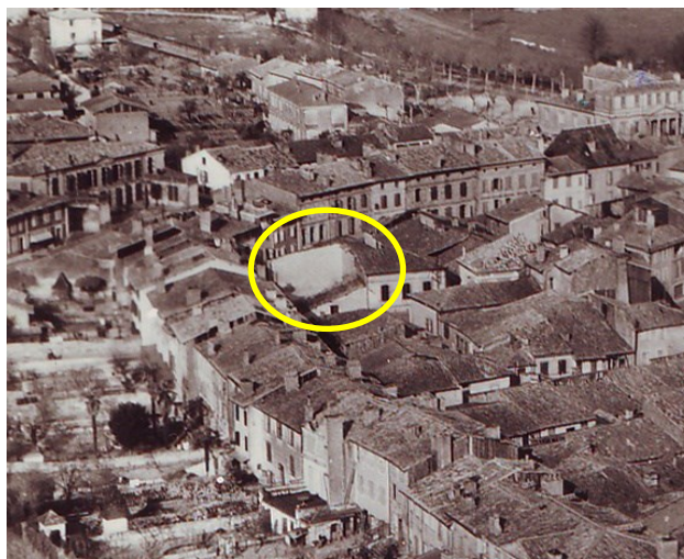
Ilot de la rue des Greniers: maisons en ruine. Moitié du XX e . Coll. J. Castex
