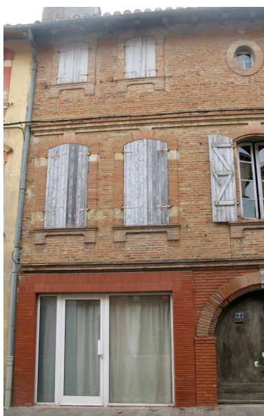
Les matériaux inappropriés : briques anciennes et briques neuves, mélange des tons. Imitation d'un parement de moellons en enduit ciment sur une maison de briques et problème de l'insertion des dispositifs d'aération.
