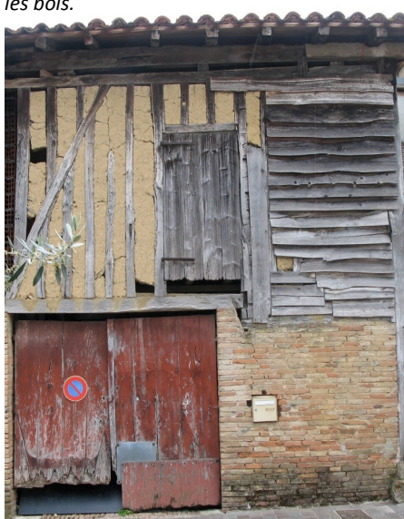
Remise rue des Greniers : rez-de-chaussée en briques maçonnées. Etage pans de bois, torchis et bardage.
