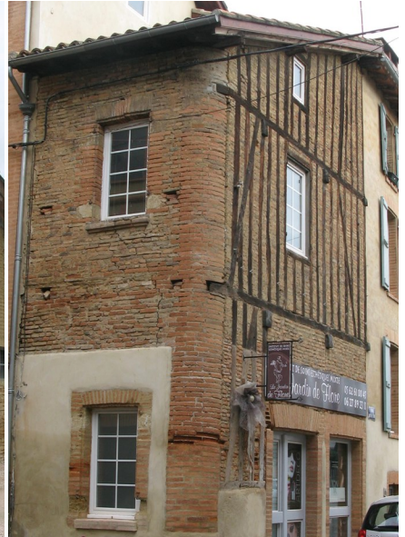
Briques de terre cuite maçonnées et hourdées en pans de bois. Absence d'enduit.
