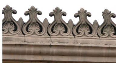
Frise décorative surplombant la corniche. Terre cuite moulée. A partir de 1830.
