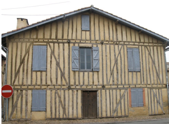
Place de la Cathédrale : pans de bois hourdés de briques et enduit .couverts par l'enduit. L'enduit ne couvre pas les bois.
