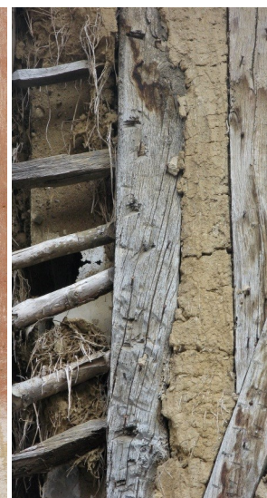
Détails d'un enduit sur briques et des éclisses dans un torchis.
