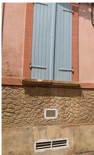
Les matériaux inappropriés : briques anciennes et briques neuves, mélange des tons. Imitation d'un parement de moellons en enduit ciment sur une maison de briques et problème de l'insertion des dispositifs d'aération.
