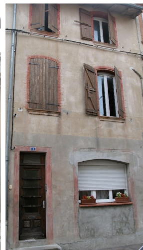
Les rez-de-chaussée, les boutiques, les percements. Symétrie des façades brisée. Non respect des gabarits, des travées, des éléments qui règlent l'art de composer la façade harmonieuse.
