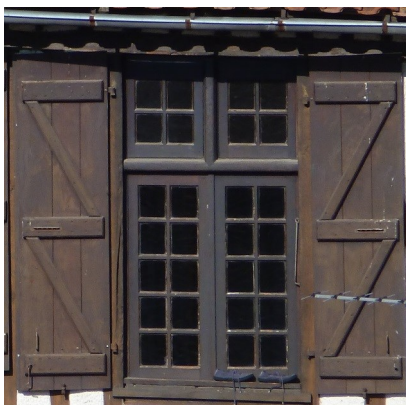
Fenêtre type XVII e à croisée et petits carreaux, encadrement bois, maison à pans de bois.
