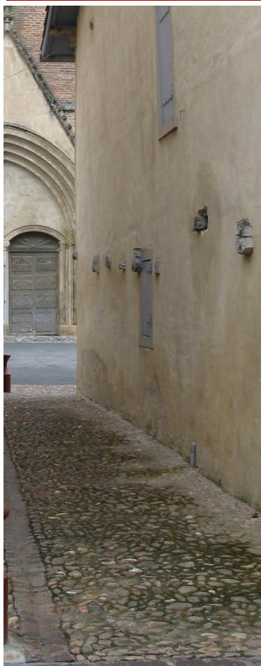
Rue pavée de galets rue des Boulangers. Fils d'eau anciens en petits galets roulés au pied des maisons.
