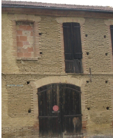
Hangar rue des Trois rois. Briques de terre crue et enduit.
