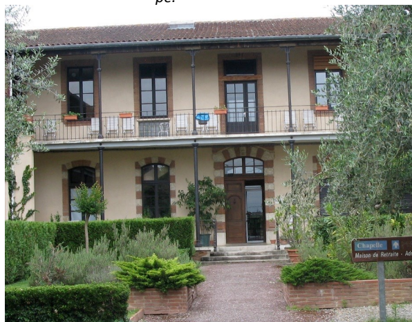
Galerie de l'hôpital. Poteaux et garde corps en fonte.
