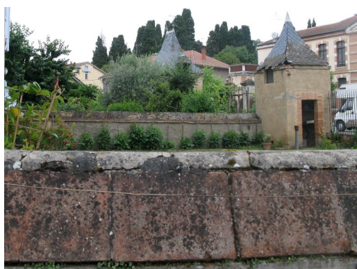
Les clôtures séparatives : murs à bâtière, enduits, tuileau.
