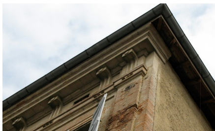
La corniche se retourne sur la façade secondaire mais ne se poursuit pas.
