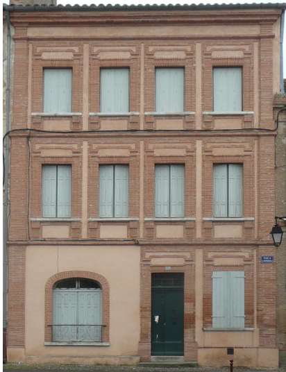
Briques de terre cuite et enduits.
