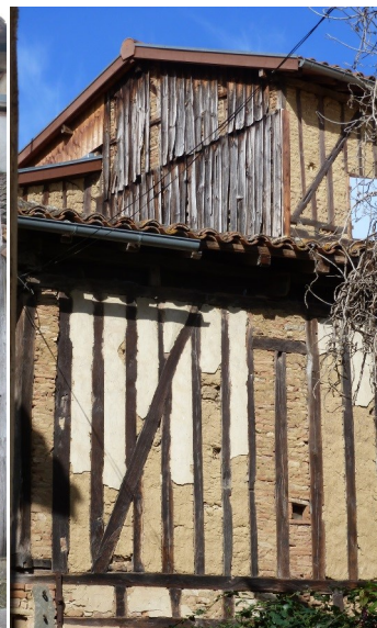
Remise pans de bois et briques, vestiges d'enduit et bardage de protection.
