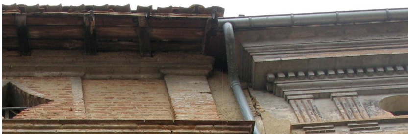
Deux types de passes de toit sur les maisons bourgeoises. A gauche 10, rue de la République, coffre de planches. Maison voisine, corniche richement ouvragée.
