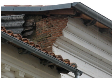
Détail d'un profil de corniche en briques avec son enduit.
