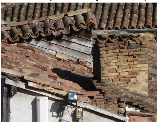
Les tuiles canal et leur assemblage, le bardage de la lucarne, les cheminées avec leur souche et leur mitre.
