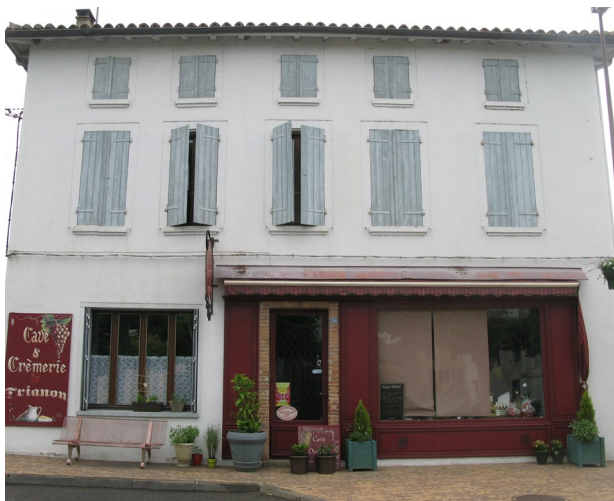
Les rez-de-chaussée, les boutiques, les percements. Symétrie des façades brisée. Non respect des gabarits, des travées, des éléments qui règlent l'art de composer la façade harmonieuse.
