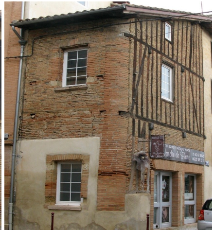
Hiérarchie des façades : brique maçonnerie sur la rue de la République et pans de bois sur la rue Notre-Dame.
