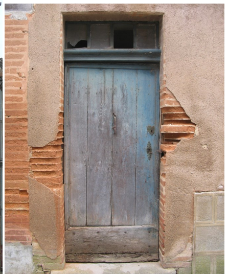
Pathologies liées aux remontées capillaires
