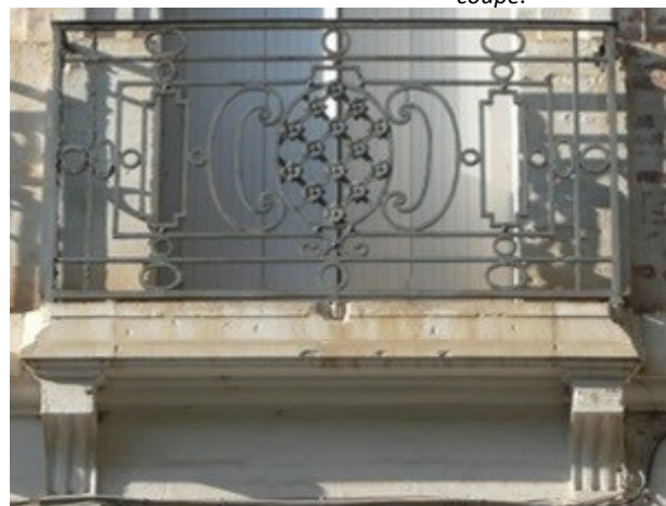
Place de la Cathédrale. Balcon en surplomb sur encorbelle- ment et garde corps en fer forgé.
