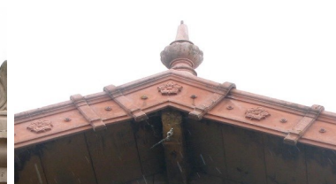
Tuiles de rive « mécaniques » décoratives et épi de faîtage en terre cuite. A partir de 1850.
