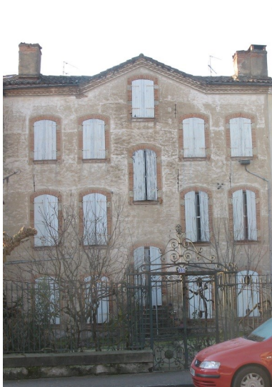
11, bd. des Pyrénées, fronton classique sur la travée centrale.
