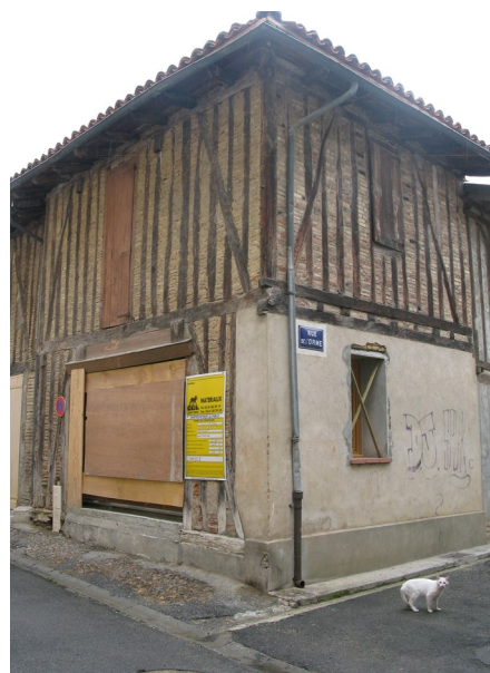
Transformation d'une remise en habitation. Exigüité et manque de luminosité du bâtiment, percements inappropriés
