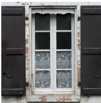
Fenêtre type XIX e . Grands carreaux, lambrequin bois découpé en casquette, fermeture des contrevents en feuillure dans l'encadrement.
