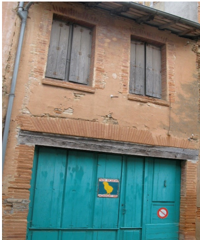
Remise. Maçonnerie de brique enduite. Rue Bertin.
