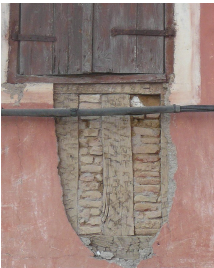
Détail d'enduit sur mur à pans de bois hourdés de terre cuite.
