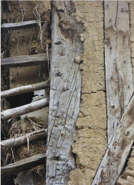
Murs en torchis. Montants et les éclisses.
