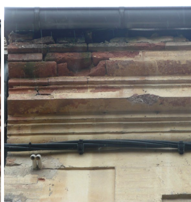
Corniche terre cuite et enduit fin.
