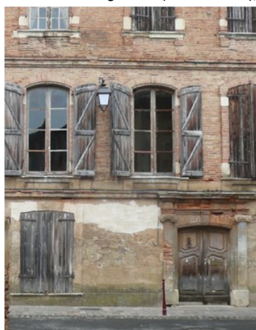
Maison 12, rue de la République. La fenêtre du rez-de-chaussée est très basse par rapport au niveau de la rue et le portail paraît trapu. La maison était construite avant que le sol ne soit exhaussé. La partie basse de la façade est enterrée. Même remarque pour l'allure trapue et écrasée du portail de la cathédrale.
