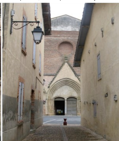
Maison 12, rue de la République. La fenêtre du rez-de-chaussée est très basse par rapport au niveau de la rue et le portail paraît trapu. La maison était construite avant que le sol ne soit exhaussé. La partie basse de la façade est enterrée. Même remarque pour l'allure trapue et écrasée du portail de la cathédrale.
