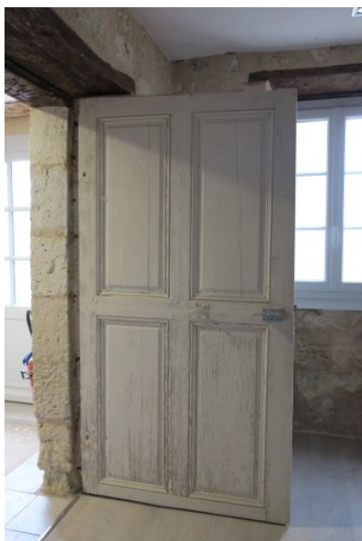
Fig. 43 - La Maison du directeur : étage de soubassement, pièce sud-ouest (porte est).
