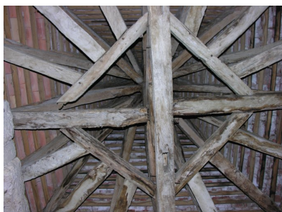
Fig. 4 - Logis : enrayure de la tour d'angle nord-est.
