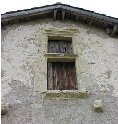
Fig. 10 - Le pignon Est et sa demi-croisée.
