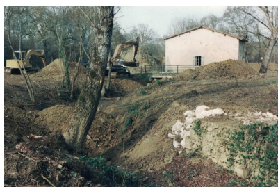
Fig. 41 - Travaux de restitution du bief de dérivation.
