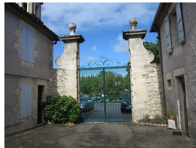
Fig. 21 - Le portail d'entrée, à l'ouest (vue intérieure).
