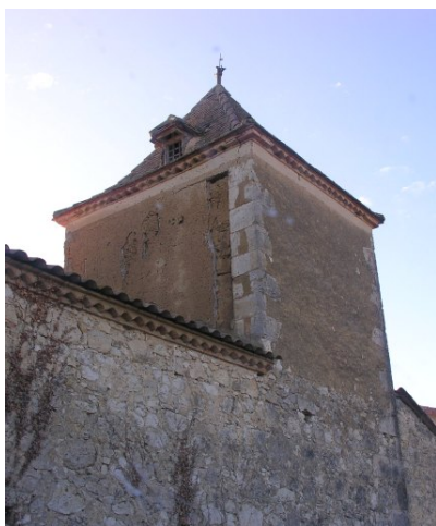
Fig. 4 - Vue nord-est du pigeonnier.
