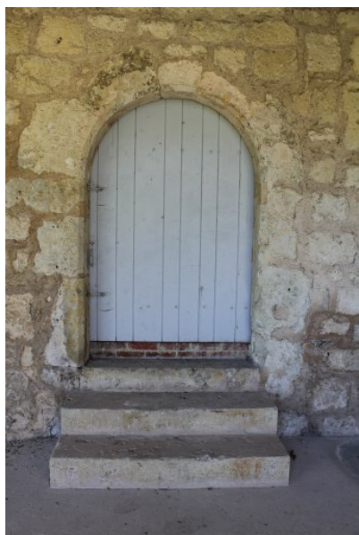
Fig. 4 - Maison : élévation ouest, porte nord ouvrant dans l'aile nord du cloître.
