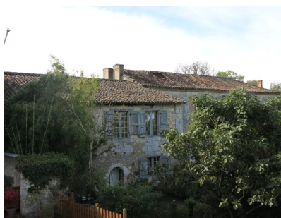
Fig. 5 - Bâtiment central (élévation nord).
