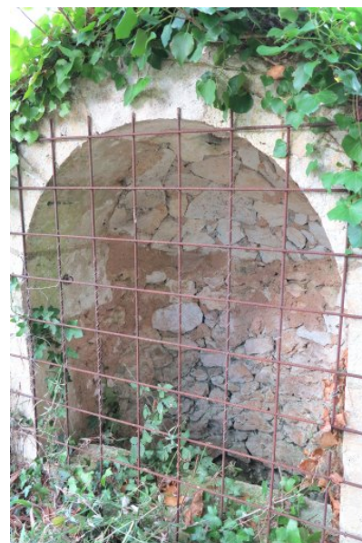
Fig. 18 - La voûte du puits.
