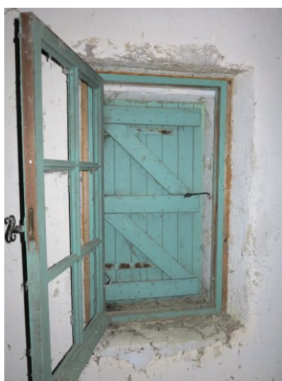
Fig. 32 - Elévation nord : petite baie éclairant le comble.
