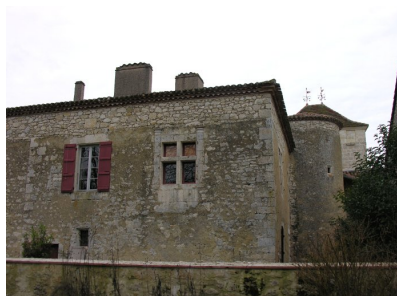
Fig. 2 - Vue sur la tour d'escalier et le corps d'entrée depuis l'ouest.
