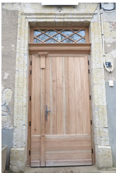
Fig. 40 - La Maison du directeur : élévation nord (détail de la porte).
