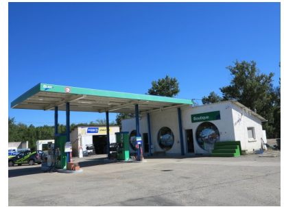
Fig. 3 - Vue d'ensemble sud.
