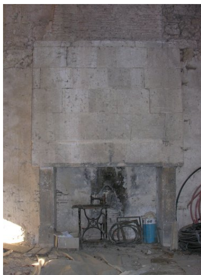
Fig. 11 - Logis : cheminée sud de l'étage.
