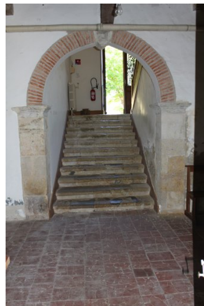
Fig. 30 - Maison : rez-de-chaussée (la première volée de l'escalier).
