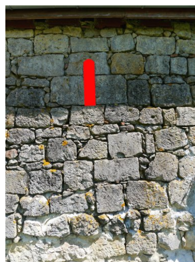
Fig. 15 - Bâtiment principal : élévation ouest (partie centrale, fenêtre bouchée indiquée en rouge).
