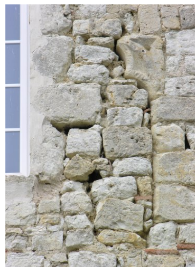
Fig. 6 - Tour médiévale : élévation sud (détail de la fenêtre trilobée).
