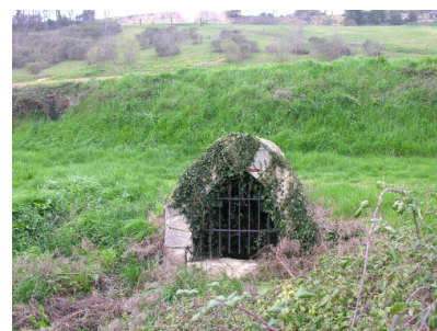
Fig. 3 - Vue d'ensemble sud.
