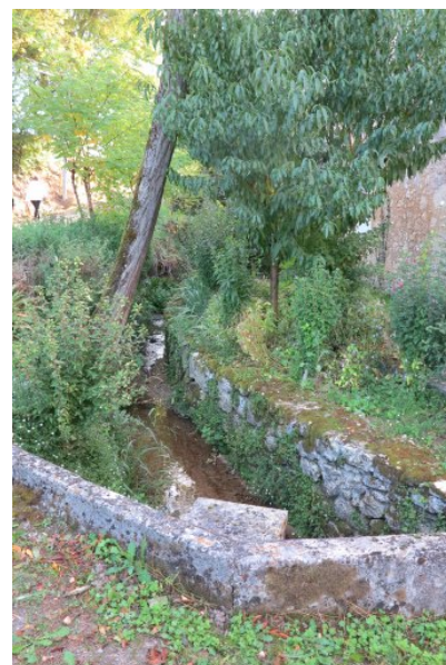
Fig. 6 - Canal : vue ouest.
