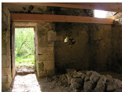
Fig. 1 - Elévation Est (vue intérieure).
