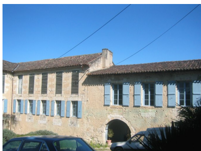
Fig. 1 - Bâtiment central et séchoir (élévations sud).
