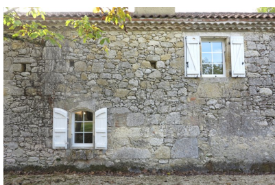
Fig. 10 - Elévation nord : partie médiane.
