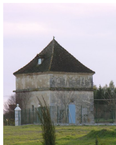
Fig. 3 - Vue nord-est du pigeonnier.
