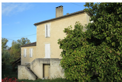
Fig. 7 - Vue d'ensemble sud-est.
