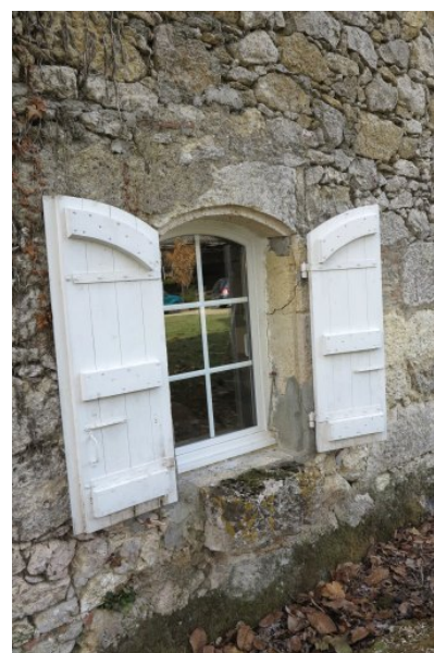
Fig. 6 - Elévation nord : partie médiane (fenêtre et pierre d'écoulement de l'évier).
