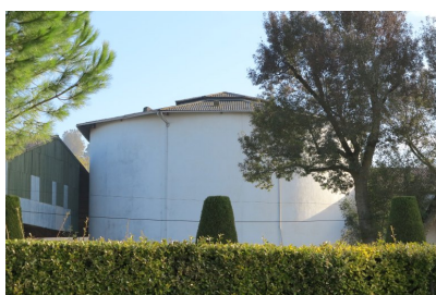
Fig. 4 - Silo nord : vue ouest.
