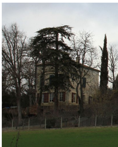
Fig. 11 - Maison (vue sud-est).
