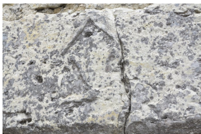
Fig. 7 - Moulin médian : vue nord (détail de la fleur de lys sculptée sur le linteau de la porte).
