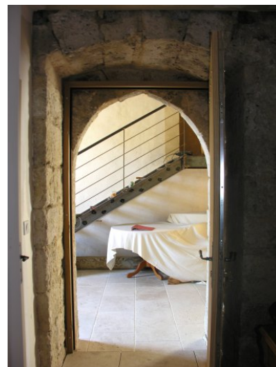
Fig. 21 - Moulin (2e niv) : élévation sud (porte, vue intérieure).
