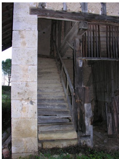
Fig. 20 - Grenier isolé (escalier).
