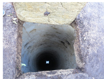
Fig. 3 - L'intérieur du puits vu du dessus.
