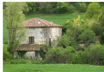
Fig. 30 - Moulin : vue nord avant travaux.
