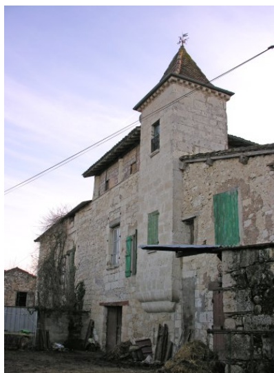
Fig. 2 - Façade du logis (vue nord).
