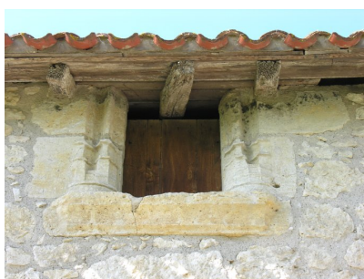
Fig. 4 - Elévation sud : fenêtre ouest de l'étage.
