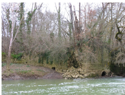
Fig. 7 - Les fondations du moulin vues du nord (rive gauche).
