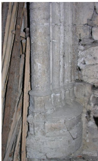
Fig. 5 - Cheminée de l'étage (détail de la base d'un piédroit).
