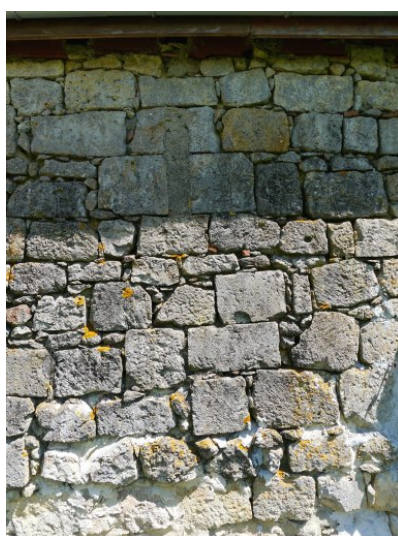
Fig. 14 - Bâtiment principal : élévation ouest (partie centrale, fenêtre bouchée).
