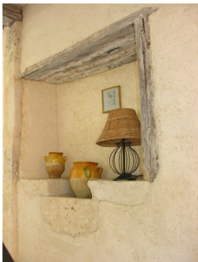
Fig. 13 - Bâtiment accolé au sud-est du moulin : élévation est (évier).
