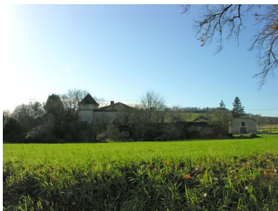
Fig. 2 - Vue d'ensemble depuis l'Est.
