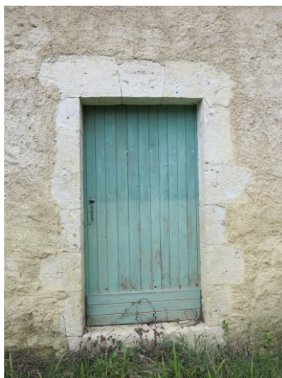
Fig. 8 - Elévation est : porte nord.
