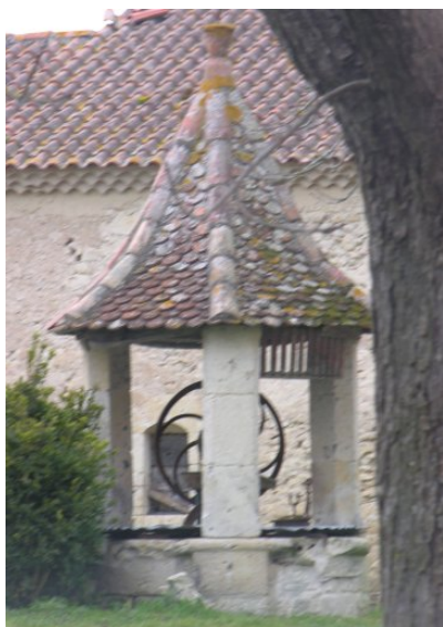
Fig. 1 - Puits (vue sud-est).
