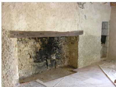
Fig. 10 - Moulin (2e niv) : élévation ouest (cheminée et latrine).
