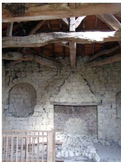
Fig. 5 - Tour médiévale : 2nd étage.
