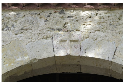
Fig. 19 - Elévation sud : porte de la grange (clé d'arc portant l'inscription "1827 STE CRX").
