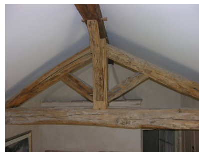
Fig. 18 - Bâtiment sud : charpente.
