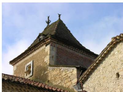
Fig. 1 - Vue nord-est du pigeonnier.
