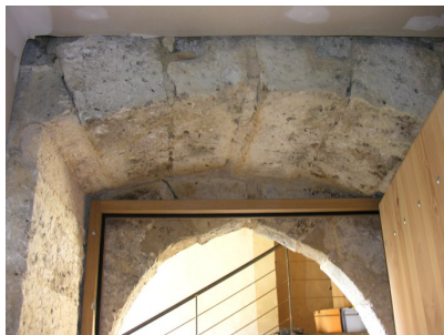
Fig. 28 - Moulin (2e niv) : élévation sud (détail de la porte, vue intérieure).
