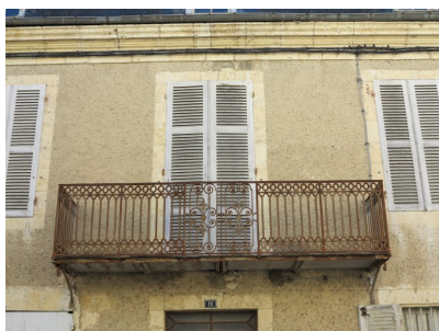
Fig. 1 - Elévation nord : détail du balcon.
