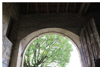
Fig. 21 - Elévation sud : porte de la grange (vue intérieure).
