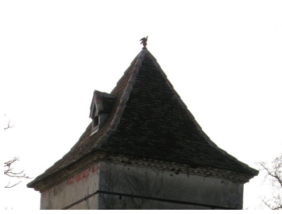
Fig. 8 - Pigeonnier : détail de la toiture.
