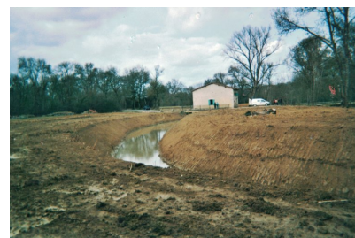
Fig. 42 - Achèvement des travaux de restitution du bief de dérivation est mise en eau.
