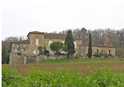
Fig. 1 - Vue d'ensemble sud.
