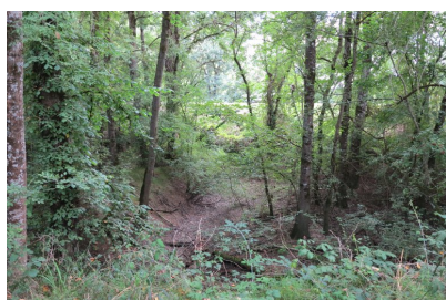
Fig. 10 - Vue du fossé sud depuis le tablier (la route Lectoure-Condom au dernier plan).
