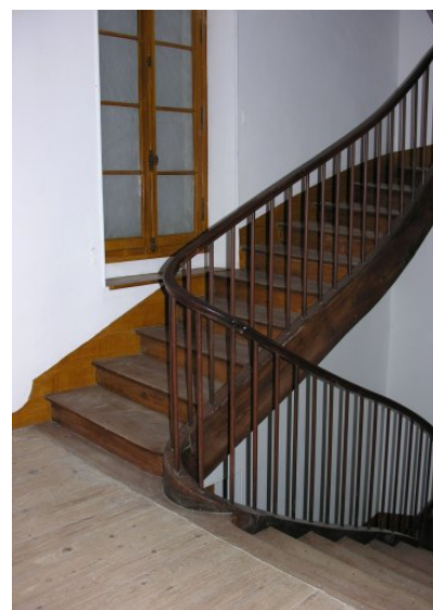
Fig. 15 - Escalier vu du 1er étage.
