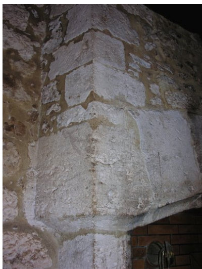
Fig. 1 - Cheminée du rez-de-chaussée (détail).
