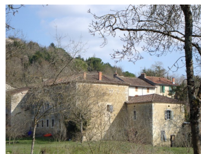
Fig. 6 - Séchoir et bâtiment sud-ouest (vue nord-ouest).
