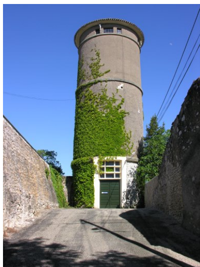
Fig. 4 - Le château d'eau (vue ouest).
