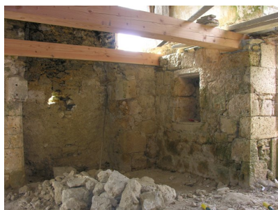
Fig. 2 - Angle sud-est (vue intérieure).
