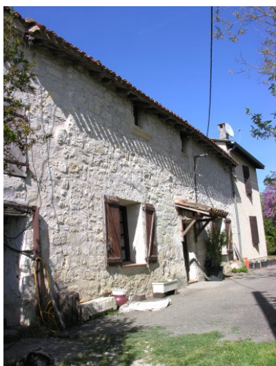
Fig. 7 - Elévation sud (vue sud-ouest).
