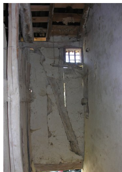
Fig. 6 - Grenier isolé (partie pigeonnier).
