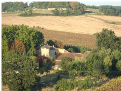
Fig. 1 - Vue aérienne nord-est.
