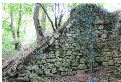
Fig. 11 - Le mur sud de la culée ouest.
