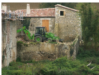
Fig. 23 - Bâtiment sud : vue nord avant travaux.
