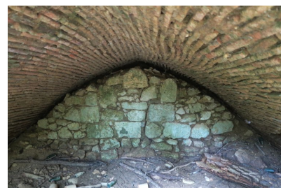
Fig. 3 - Le mur obturant l'accès nord de l'arche (vue sud).
