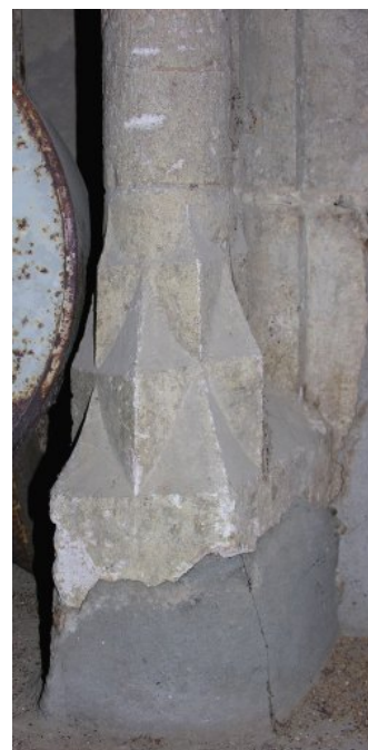
Fig. 3 - Détail de la base d'un piédroit de la cheminée nord-ouest de l'étage.
