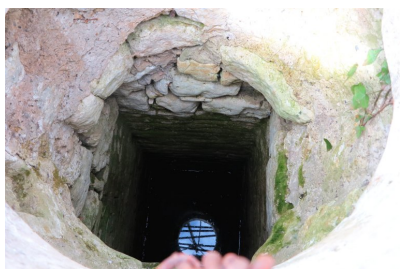
Fig. 7 - Métairie : puits (vue intérieure de la section carrée).
