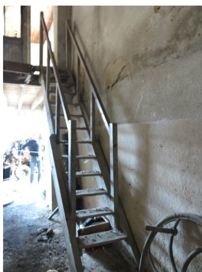
Fig. 23 - Salle des machines : l'échelle de meunier contre l'élévation est.
