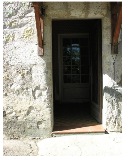
Fig. 12 - Elévation sud : porte d'entrée.
