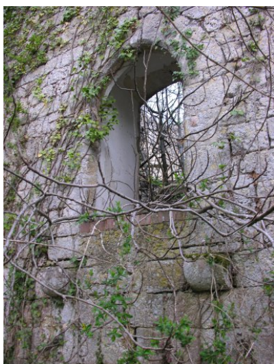
Fig. 4 - Fenêtre ouest du rez-de-chaussée.
