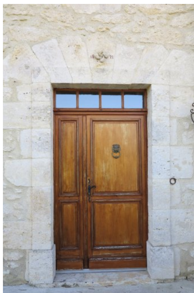
Fig. 2 - Elévation nord (porte d'entrée).
