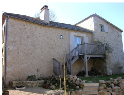
Fig. 17 - Bâtiment sud : élévation nord.
