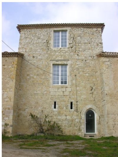
Fig. 13 - Tour médiévale : élévation sud.
