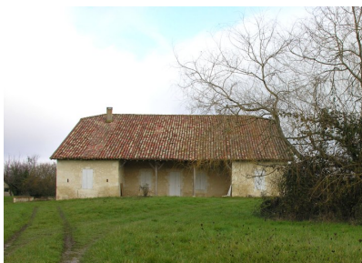
Fig. 17 - Métairie : élévation sud.
