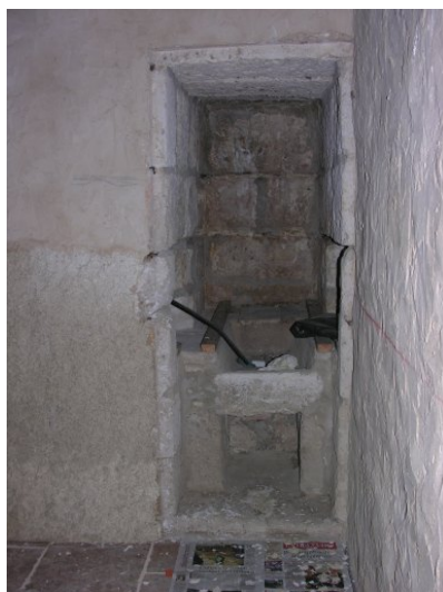
Fig. 2 - Moulin (2e niv) : élévation ouest (latrine, vue intérieure).
