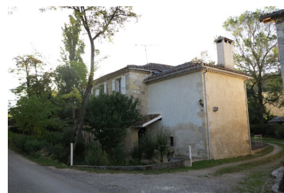
Fig. 3 - Moulin : vue nord-ouest.
