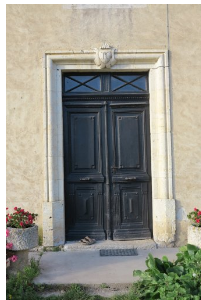
Fig. 3 - Elévation nord-est : porte d'entrée principale.
