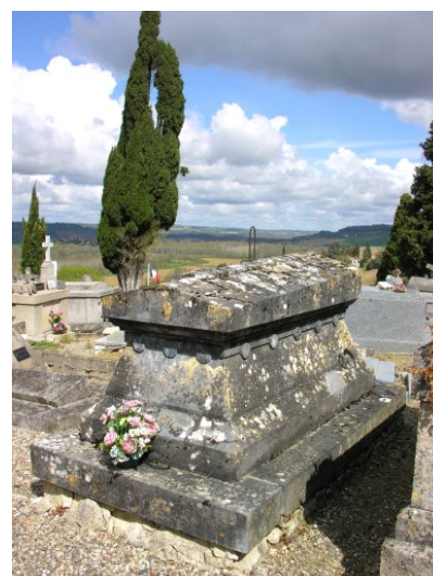
Fig. 6 - Caveau en pierre.
