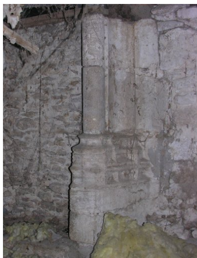
Fig. 2 - Piédroit de la cheminée de l'étage.
