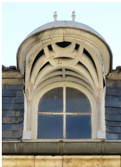
Fig. 5 - Brisis : détail de la lucarne centrale.
