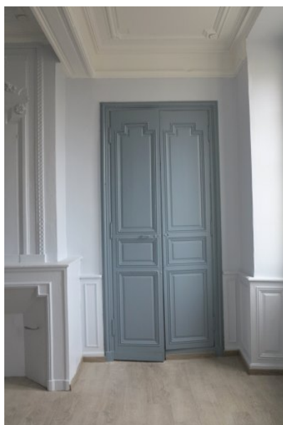
Fig. 8 - La Maison du directeur : rez-de-chaussée, pièce sud-est (porte).
