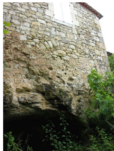
Fig. 3 - Ancienne étable : élévation sud.
