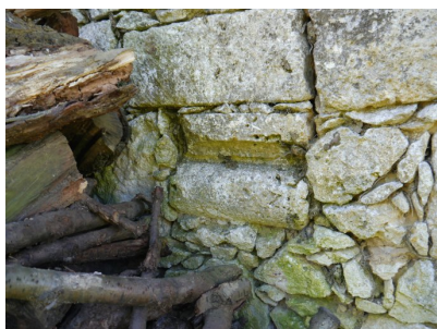
Fig. 1 - Grange : élévation nord (fût de colonnette en remploi).
