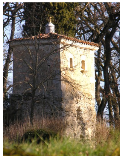
Fig. 3 - Vue sud du pigeonnier.
