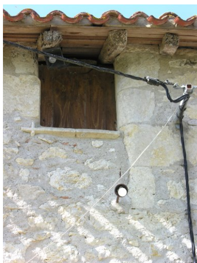
Fig. 14 - Elévation sud : fenêtre Est de l'étage.
