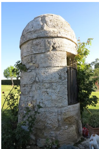
Fig. 10 - Le puits (vue sud-ouest).
