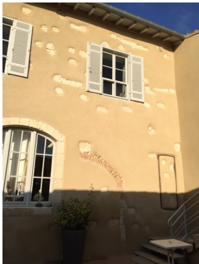
Fig. 16 - Eglise : élévation sud, moitié est (traces d'une arcade en brique et pierre).
