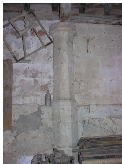
Fig. 15 - Un pilier de la galerie, vu de l'intérieur.
