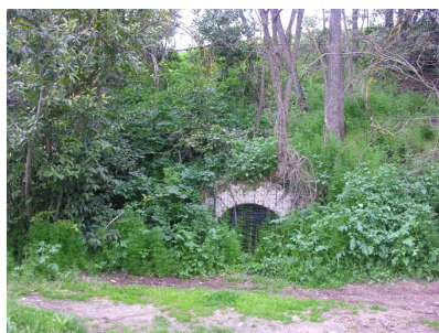
Fig. 2 - Vue d'ensemble sud.
