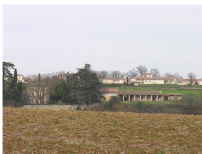
Fig. 4 - Vue d'ensemble sud.
