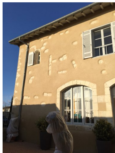
Fig. 3 - Eglise : élévation sud, moitié ouest (petite fenêtre cintrée).
