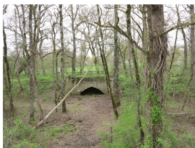
Fig. 4 - Vue d'ensemble sud.
