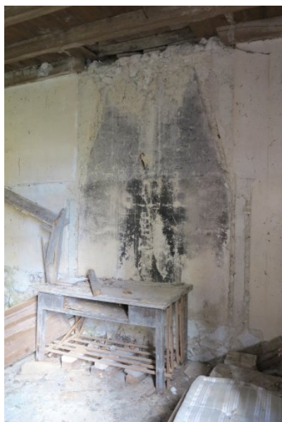
Fig. 5 - Pièce ouest : élévation ouest.
