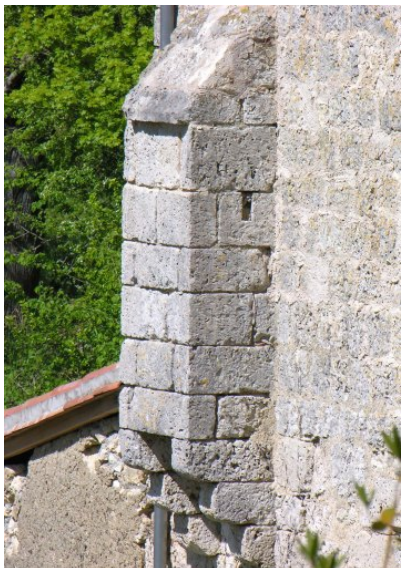
Fig. 8 - Moulin (2e niv) : élévation ouest (latrine, vue sud).
