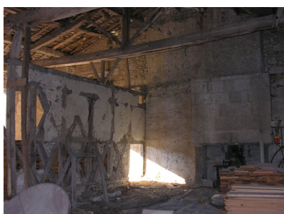
Fig. 16 - Logis : salle sud-est de l'étage.
