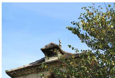
Fig. 2 - Vue sud (le toit du pigeonnier).
