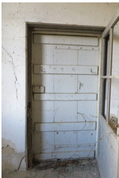
Fig. 4 - Elévation est : porte vue de l'intérieur.
