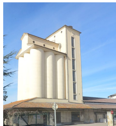
Fig. 6 - Silo sud : vue est.
