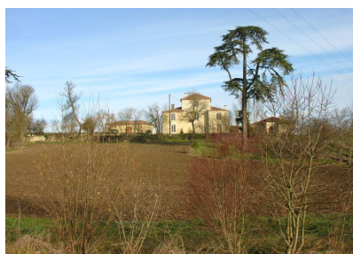
Fig. 11 - Vue d'ensemble sud.
