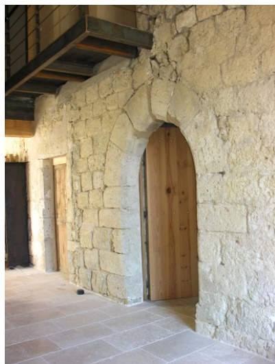
Fig. 35 - Moulin (2e niv) : élévation sud (porte, vue est).
