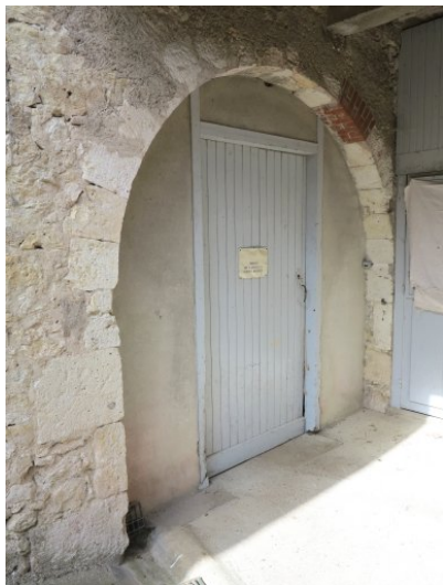
Fig. 10 - Aile sud : élévation nord (vestige d'une porte charretière en plein cintre).
