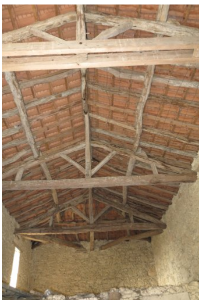
Fig. 23 - Charpente de la grange et de l'étable.
