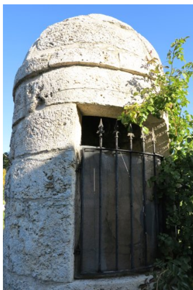
Fig. 5 - Le puits (vue sud).
