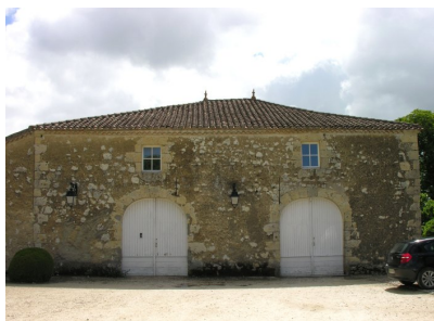
Fig. 19 - Anciennes écuries : élévation ouest.
