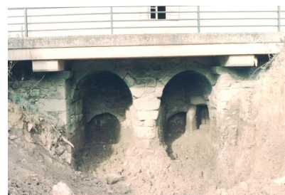
Fig. 39 - Elévation sud : deux arches lors de l'assèchement du bief de dérivation.
