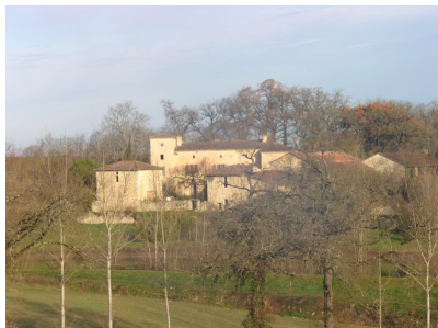
Fig. 1 - Vue d'ensemble sud.
