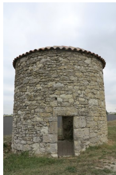
Fig. 3 - Moulin médian : vue sud.
