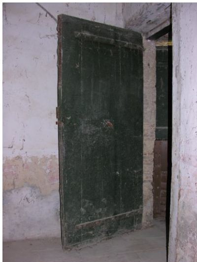
Fig. 28 - Salle ouest rdc (porte).
