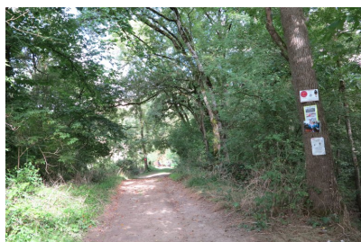
Fig. 2 - Le tablier du pont se confondant avec le chemin (vue ouest).
