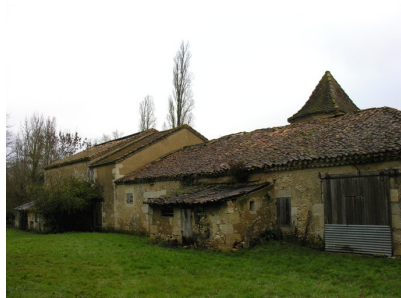
Fig. 4 - Ferme (élévation postérieure).
