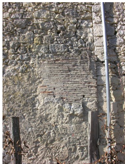
Fig. 15 - Bâtiment accolé au sud-est du moulin : élévation est (évier, vue extérieure).
