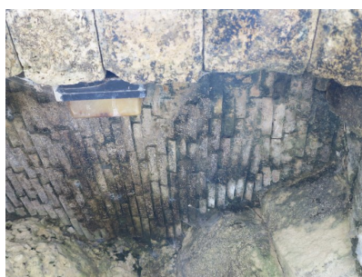
Fig. 5 - Fontaine maçonnée (détail de la voûte).
