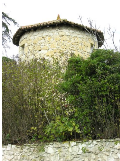
Fig. 5 - Moulin ouest : vue sud.
