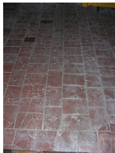
Fig. 33 - Maison : rez-de-chaussée (revêtement de sol au bas de l'escalier).
