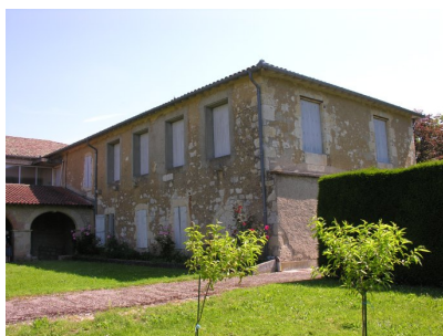
Fig. 22 - Maison : vue sud-ouest.
