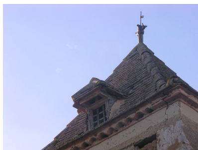
Fig. 2 - Détail du versant Est de la toiture du pigeonnier.
