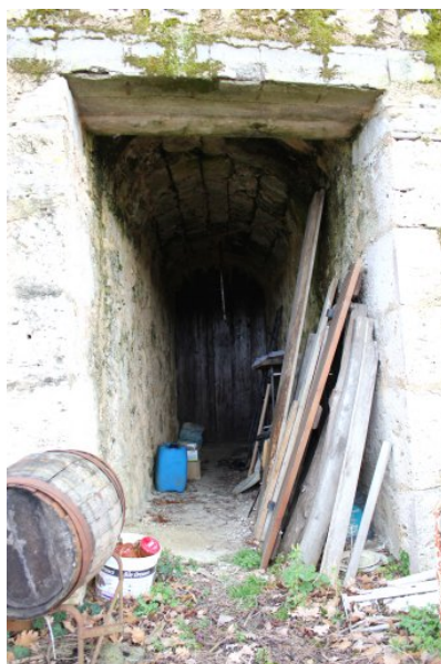
Fig. 2 - Maison : un couloir supportant la terrasse.
