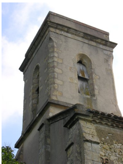
Fig. 1 - Vue sud-ouest du clocher.
