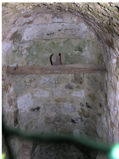
Fig. 4 - Intérieur de la superstructure maçonnée.
