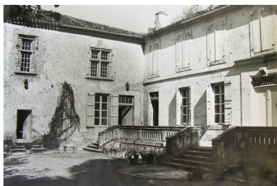
Fig. 1 - Vue sud-est sur les logis.
