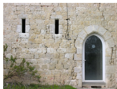
Fig. 12 - Tour médiévale : élévation sud (rez-de-chaussée).
