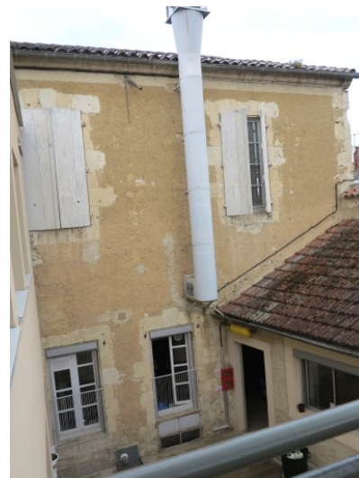
Fig. 6 - Ancien séminaire : bâtiment situé au nord sur le cadastre de 1824 (dépendance ?), élévation est.
