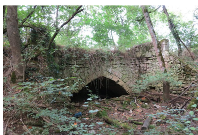
Fig. 8 - Vue d'ensemble sud.
