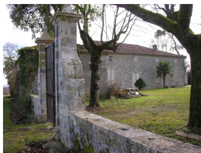
Fig. 5 - Maison : élévation ouest (sur cour).
