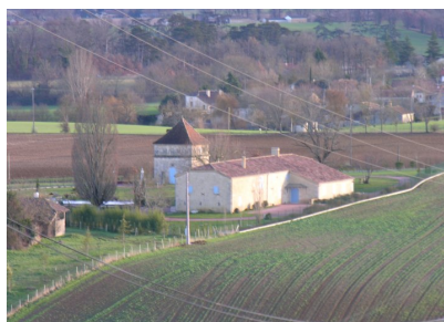
Fig. 4 - Vue d'ensemble depuis le nord.
