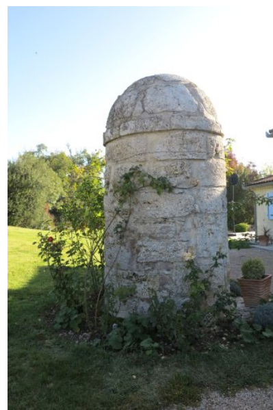
Fig. 6 - Le puits (vue nord-ouest).
