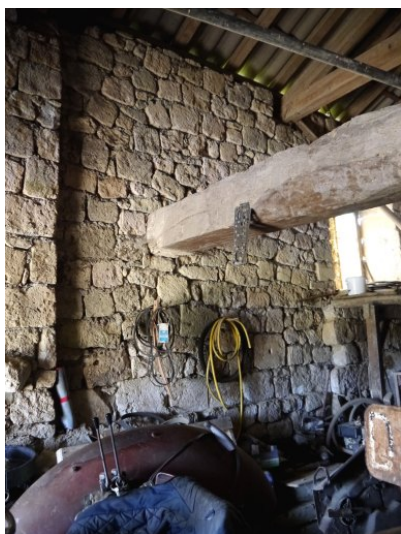
Fig. 31 - Bâtiment principal : élévation ouest (partie sud).
