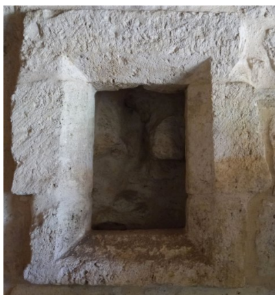
Fig. 34 - Bâtiment principal : fenêtre de l'évier elle aussi déplacée.
