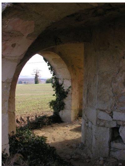
Fig. 1 - Intérieur du rez-de-chaussée.
