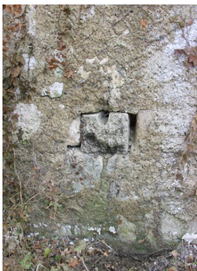
Fig. 7 - Elévation ouest : évacuation (vue extérieure).
