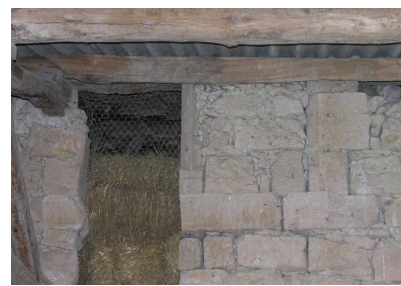
Fig. 3 - Fenêtre sud-ouest de l'étage.
