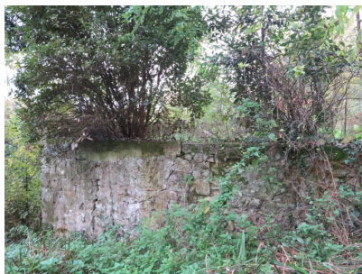
Fig. 16 - Mur de soutènement ouest du jardin.
