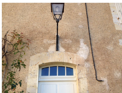
Fig. 8 - Dépendance : porte du logement surmontée d'une croix peinte.
