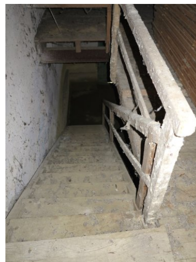
Fig. 30 - Comble : escalier d'accès.
