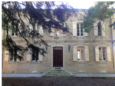
Fig. 11 - Maison : élévation ouest.
