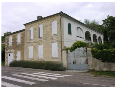
Fig. 4 - Vue d'ensemble sud-ouest.
