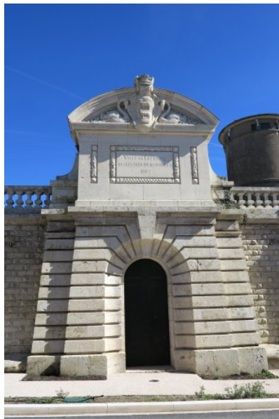
Fig. 11 - Elévation ouest (avant-corps central).
