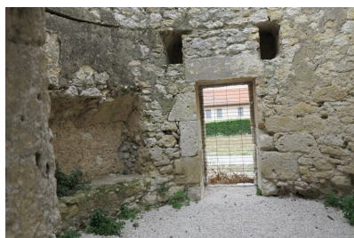
Fig. 14 - Moulin est : intérieur (moitié sud).
