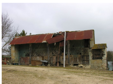
Fig. 2 - Séchoir : vue sud-ouest.
