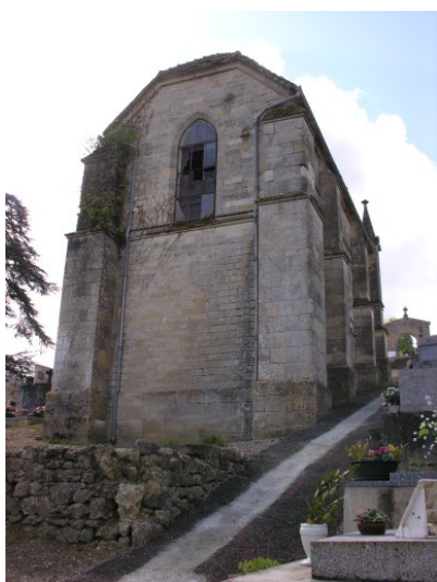
Fig. 19 - La chapelle : élévation nord.
