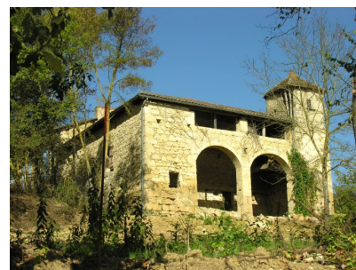
Fig. 3 - Elévation sud : arcades ouvertes en 2012.
