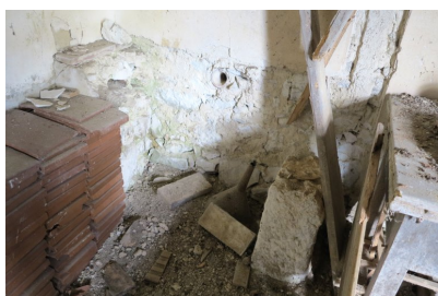
Fig. 13 - Pièce ouest : élévation ouest (vestige d'évier).
