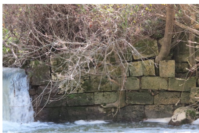
Fig. 37 - Partie ouest de la digue.
