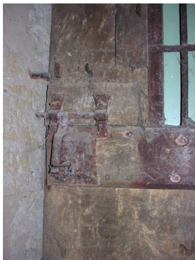
Fig. 23 - Maison : soubassement (serrure de la porte d'entrée sud).
