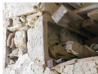
Fig. 6 - Bâtiment principal : élévation Est actuelle doublant l'ancienne (évier en remploi).
