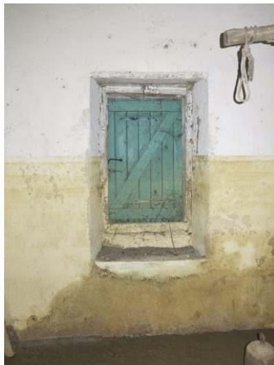
Fig. 20 - Elévation ouest : fenêtre (vue intérieure).
