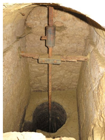
Fig. 24 - Meules est : fusée ou barre de transmission.
