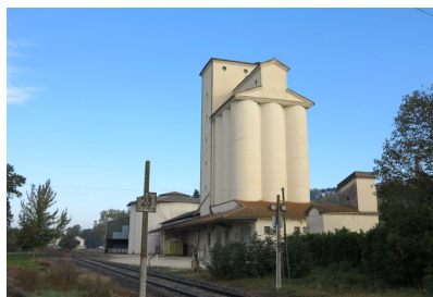
Fig. 8 - Silo sud : vue sud.
