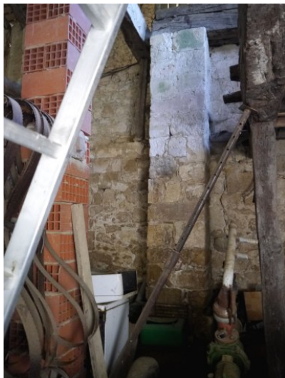
Fig. 10 - Bâtiment principal : élévation Est (partie sud, contrefort intérieur).
