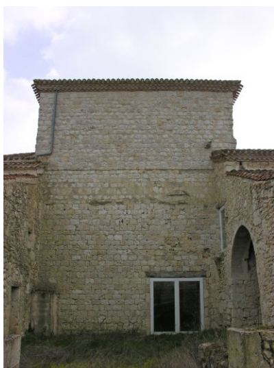
Fig. 7 - Tour médiévale : élévation nord.
