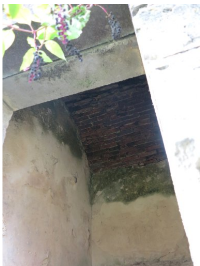
Fig. 10 - Latrine nord (voûte).
