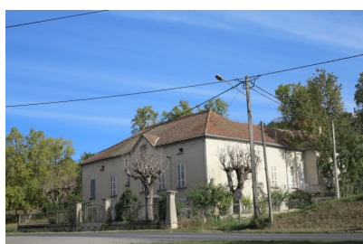
Fig. 7 - Maison : vue sud-est.
