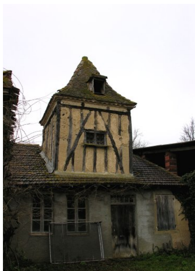
Fig. 2 - Ferme (élévation antérieure de la partie ouest).
