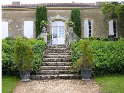
Fig. 16 - Maison : élévation ouest.
