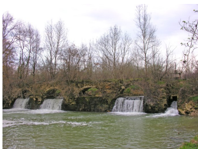
Fig. 1 - Vue d'ensemble depuis le nord (rive gauche).
