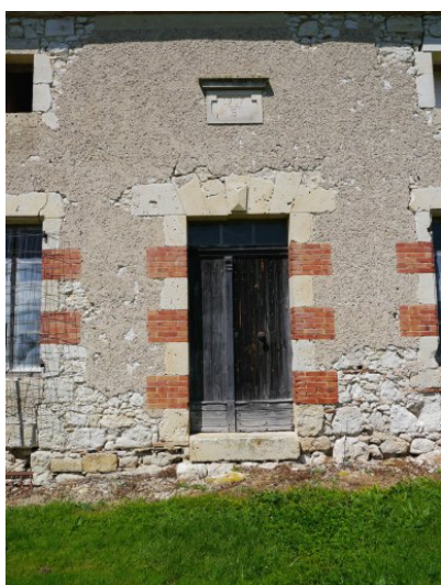
Fig. 7 - Maison : élévation sud (porte).
