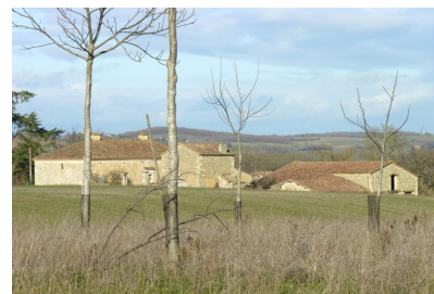
Fig. 3 - Vue d'ensemble sud.
