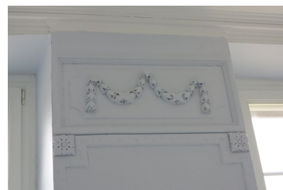
Fig. 6 - La Maison du directeur : rez-de-chaussée, pièce sud-est (gypserie).
