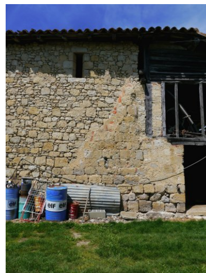
Fig. 21 - Bâtiment principal : élévation sud (détail de l'angle sud-est d'origine conservé).
