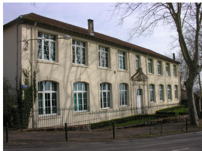
Fig. 29 - Bâtiment des classes : élévation ouest.
