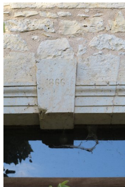
Fig. 3 - Bâtiment principal : élévation est (détail de la plate-bande de la porte d'entrée).
