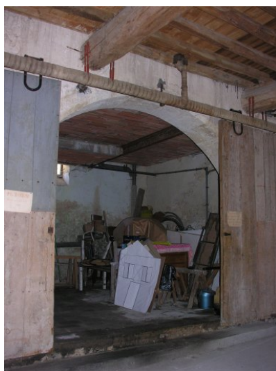
Fig. 14 - Eglise : élévation nord, arcade ouvrant sur ce qui était le bras nord du transept).
