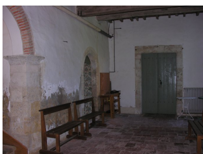
Fig. 37 - Maison : rez-de-chaussée (partie située au sud de l'escalier).
