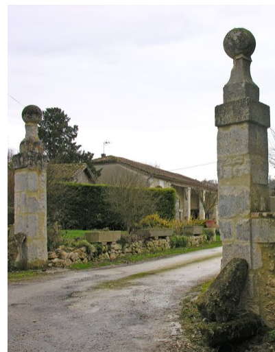
Fig. 3 - Vue nord (depuis le portail).
