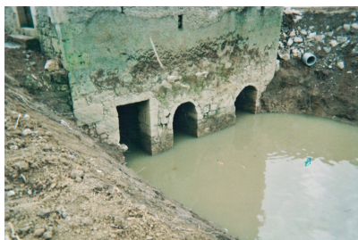
Fig. 40 - Elévation nord : ouvertures de trois passages d'eau dont deux arches, lors de l'assèchement du bief de dérivation.
