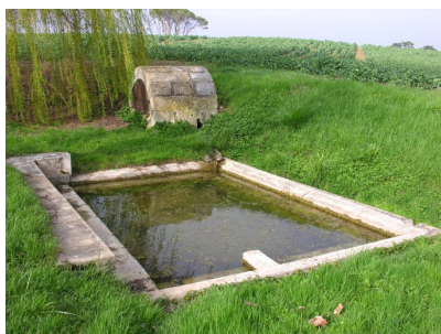
Fig. 1 - Vue d'ensemble sud.
