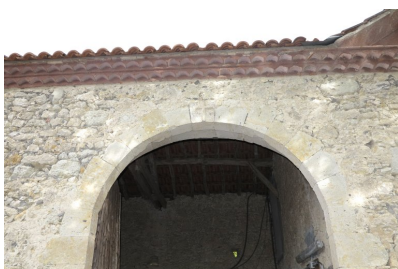
Fig. 20 - Elévation sud : porte de la grange.
