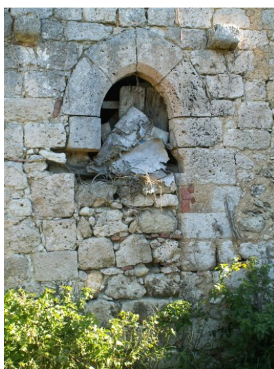
Fig. 41 - Moulin (1er niv) : élévation ouest (baie avant travaux).
