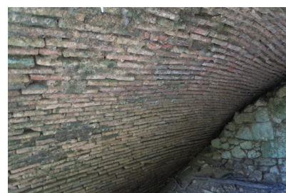
Fig. 12 - Détail de la voûte en brique.
