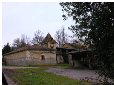
Fig. 5 - Ferme vue depuis le sud-est.
