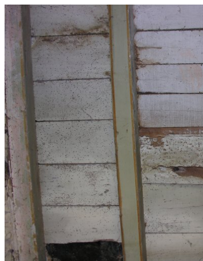
Fig. 18 - Salle ouest rdc (plafond).
