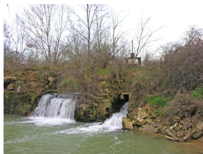
Fig. 8 - Extrémité ouest du pont vue du nord (rive gauche).
