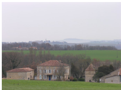
Fig. 4 - Vue des bâtiments anciens depuis le sud.
