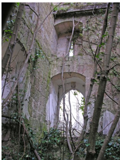
Fig. 1 - Vue sud-ouest de l'intérieur.
