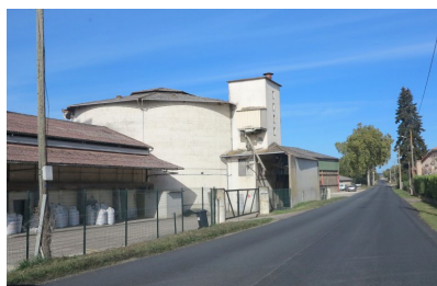
Fig. 2 - Silo nord : vue est.
