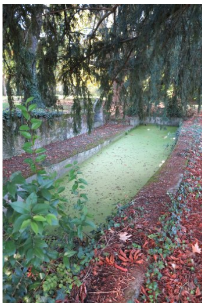
Fig. 1 - Bassin : vue ouest.
