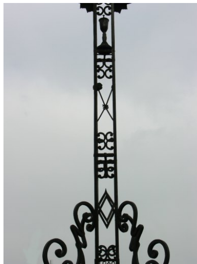
Fig. 5 - Moitié inférieure de la croix (vue sud).
