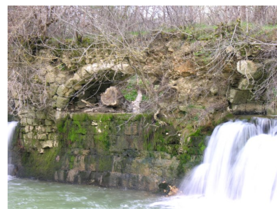
Fig. 3 - Détail d'une arche du pont.
