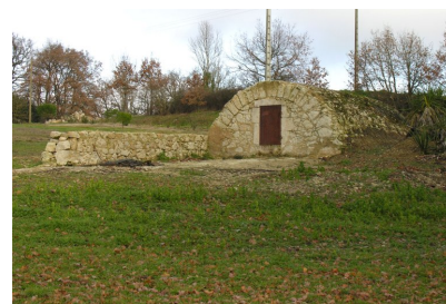
Fig. 3 - Vue sud du réservoir.
