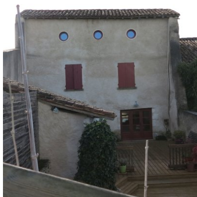
Fig. 8 - Bâtiment est (élévation nord).
