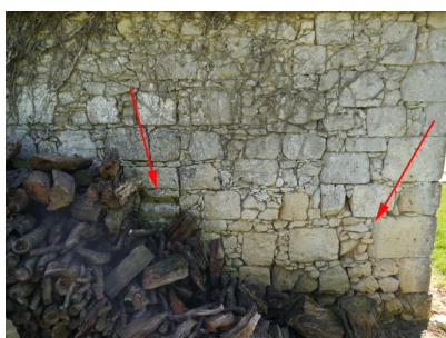
Fig. 4 - Grange : élévation nord (indication de deux remplois).
