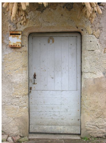
Fig. 7 - Elévation nord (porte d'entrée).
