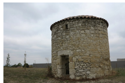
Fig. 15 - Moulin est : vue sud.
