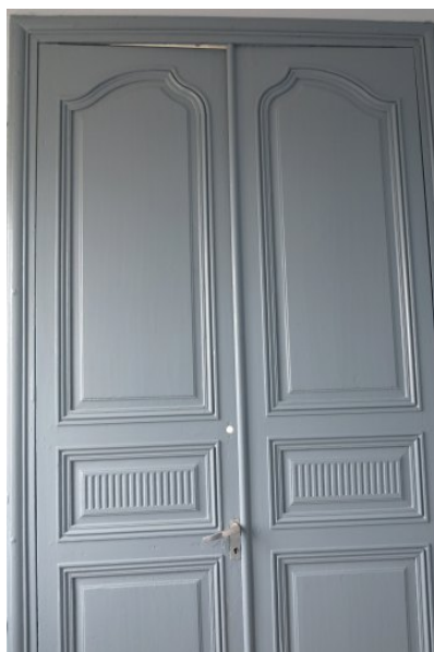
Fig. 38 - La Maison du directeur : rez-de-chaussée, pièce sud-ouest (porte).
