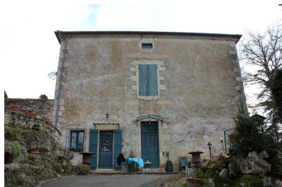
Fig. 14 - Maison : élévation ouest.
