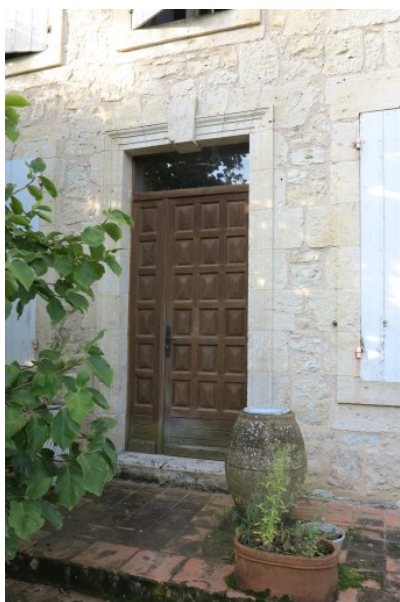
Fig. 4 - Bâtiment principal : élévation est (porte d'entrée).
