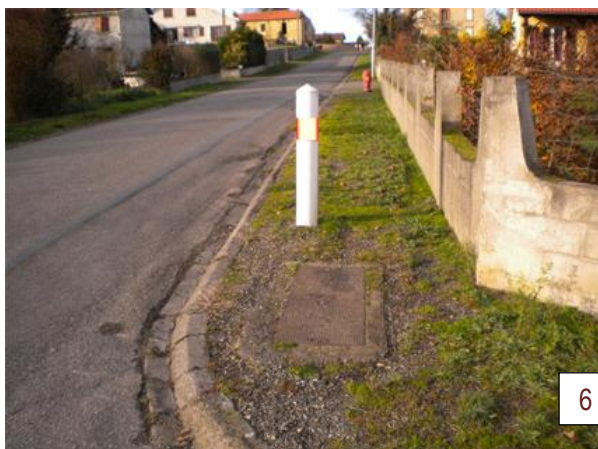
6 - Vue sur une chambre de tirage sur le réseau principal enterré d'alimentation en téléphone le long de la RD 261
