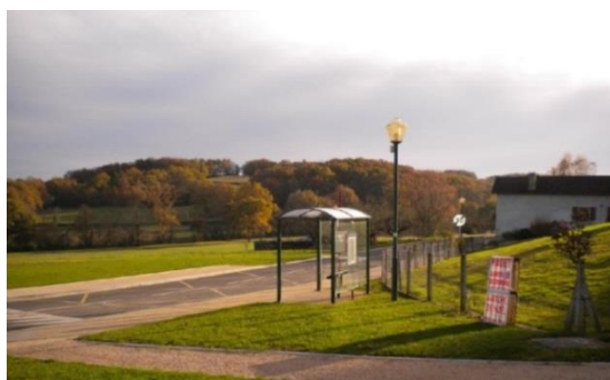
Sur ce cliché, on remarque aisément l'aménagement ponctuel au niveau de l'arrêt de bus, avec ce candélabre de proximité. Ce type d'éclairage se continue sur la RD 280, jusqu'à la fin de l'aménagement
