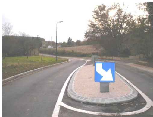
Sur cette fin d'aménagement, marqué par l'ilot central, un candélabre de type routier a été positionné
