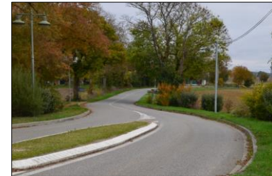
La sortie Nord-Est par la RD 39 Source : L'Artifex
