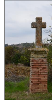
Croix de chemin en béton Source : L'Artifex
