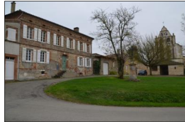
Vue sur la place de l'église d'Encausse en 2016, photo-reconstitution Source : L'Artifex
