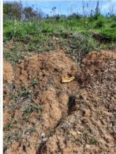
Vue d'un drain en limite du champs Photo SOE 04-2024
