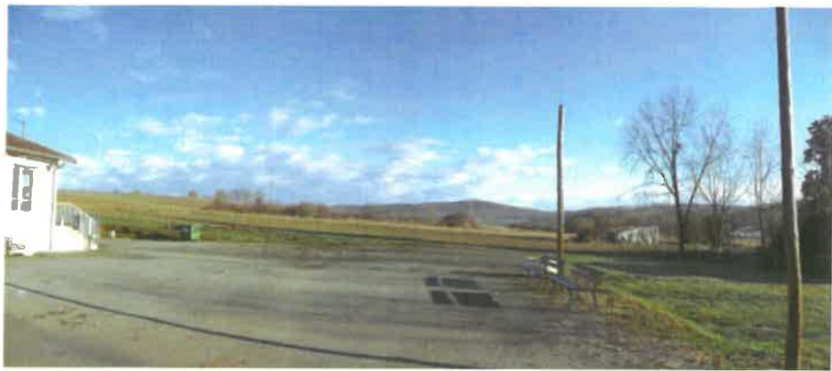
Place de la mairie/ salle polyvalente à qualifier notamment grâce à l'accueil d'une opération dense formant un front bâti parallèlement à la RD 83
