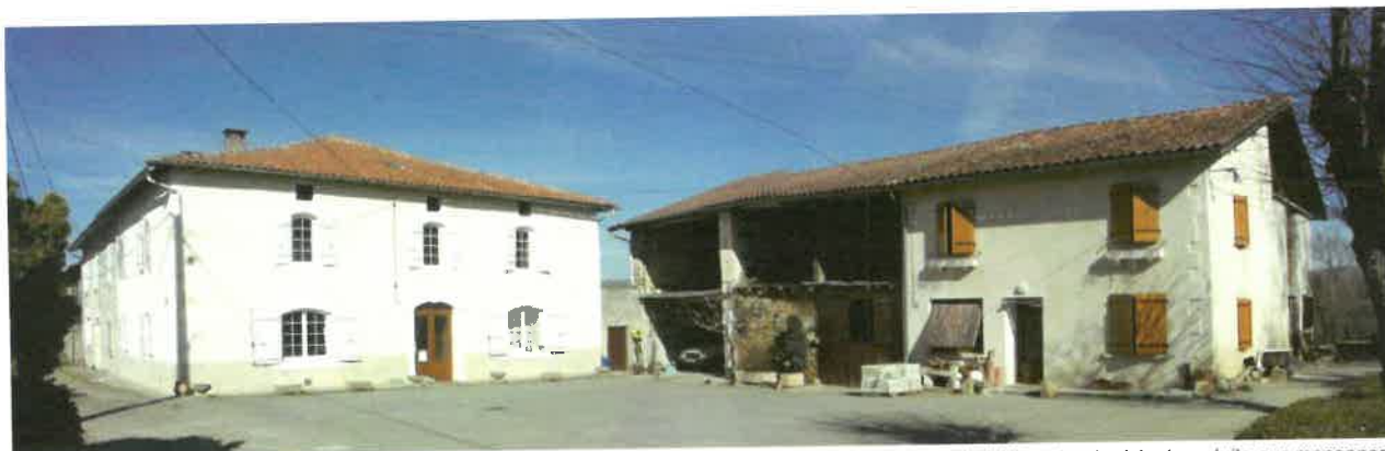
Corps de ferme dans lequel une opération de changement de destination a été réalisé sans respect du bâtiment préexistant: enduits sur maçonnerie traditionnellement non enduit - proportion d'ouverture standardisée
