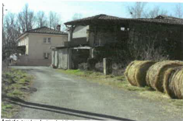
Arrivée sur Loubeto : habitations et anciens bâtiments agricoles.
