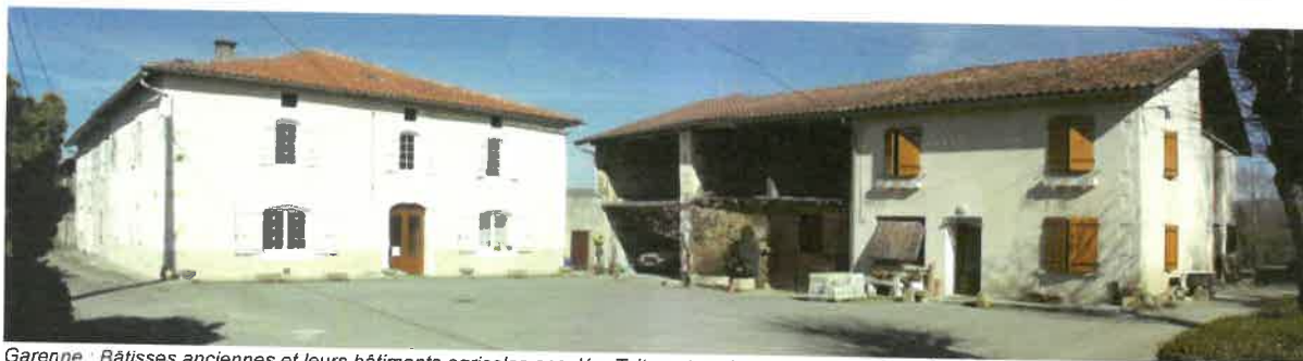
Garenne : Bâtisses anciennes et leurs bâtiments agricoles accolés. Toiture 4 ou à 2 pans avec des pentes très faibles.
