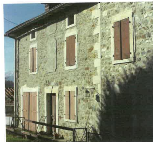
Façades présentant les caractéristiques d'une façade devant être enduite (surépaisseur des encadrements d'ouvertures)
