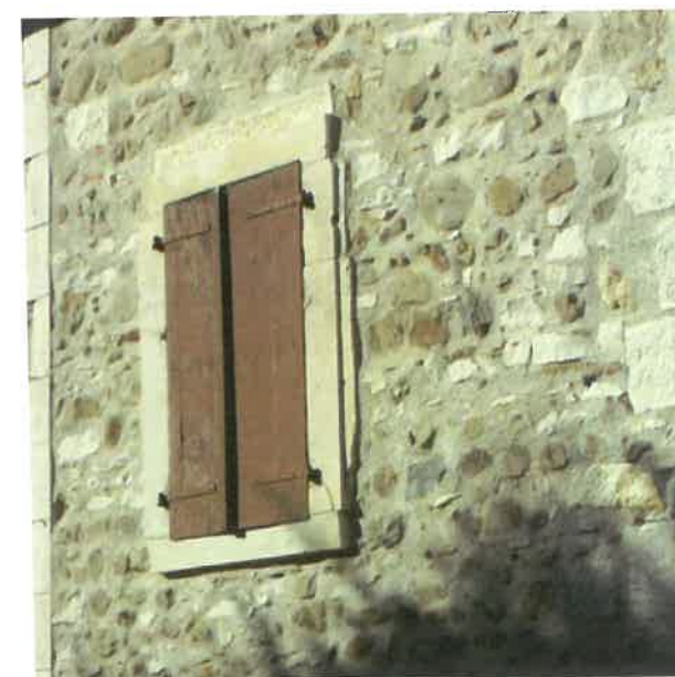
Façades présentant les caractéristiques d'une façade devant être enduite (surépaisseur des encadrements d'ouvertures)
