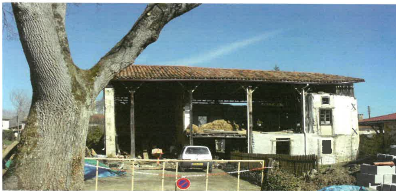
Création d'ouvertures correspondant à des standards de fabrication et non représentative de l'architecture locale.
