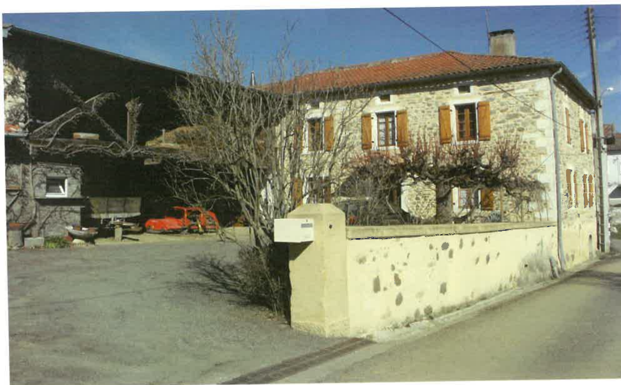
Corps de ferme dans lequel une opération de changement de destination a été réalisé sans respect du bâtiment préexistant: enduits sur maçonnerie traditionnellement non enduit - proportion d'ouverture standardisée
