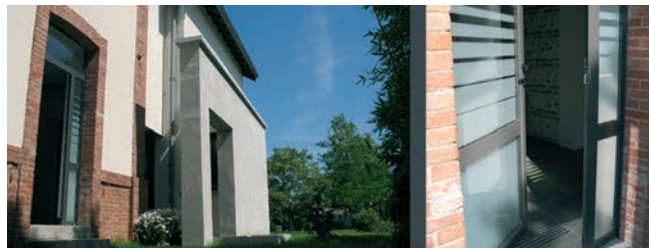
Rénovation – Archi. Pilon et Georges
