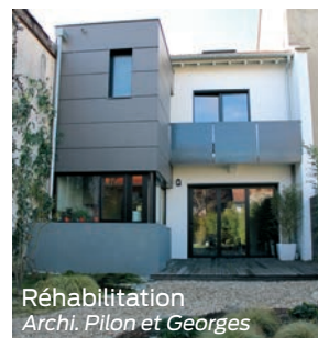
Exemples de densification et rénovation
