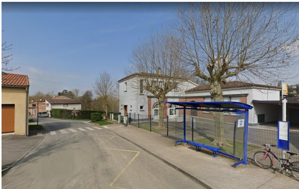
Aménagements piétons sécurisés devant l'école
