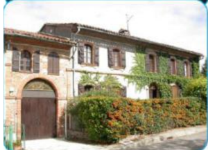
2 maisons de notable : Maisons fin 18ème début 19ème. La première a subi une rénovation récente sur sa partie orientale.
