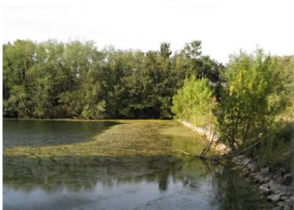
Retenue collinaire à proximité d'En Combes
