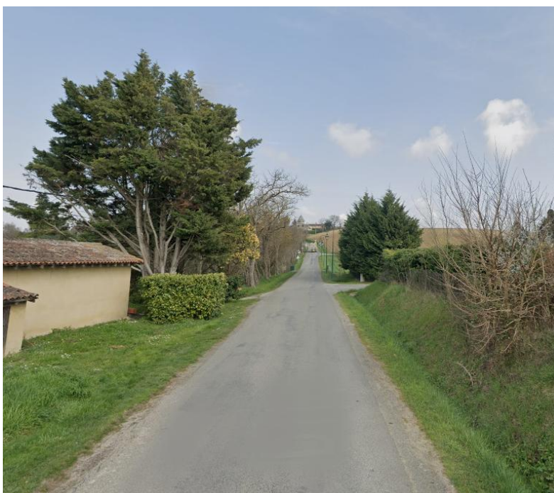
Accotements non aménagés vers la salle des fêtes
