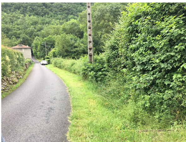
VC 17 en façade vers l'Ouest
