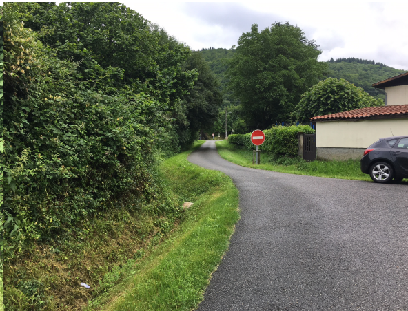
VC n° 17 en façade vers l'Est
