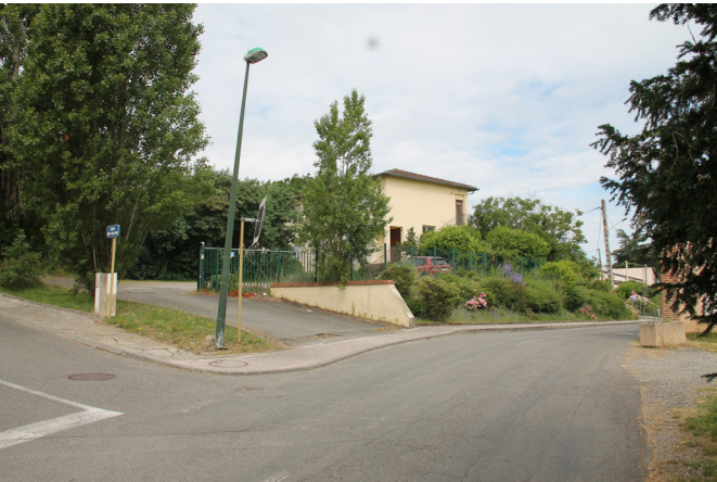
Bâtiments existants sur la parcelle n°1 et 2
