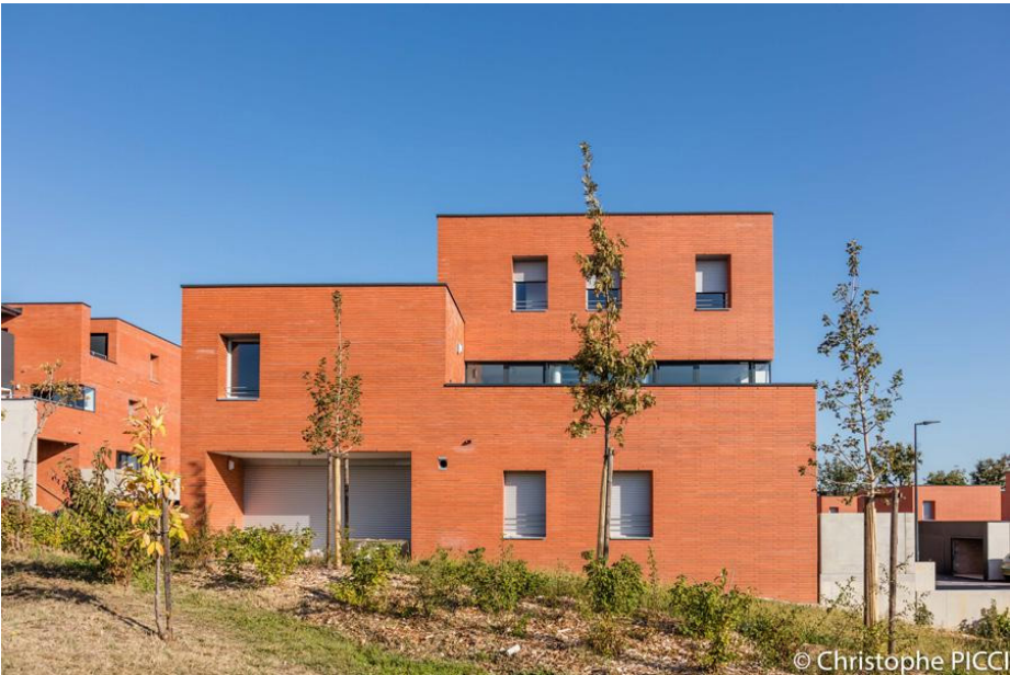
Étages en attique, ZAC Monges à Cornebarrieu (31)
