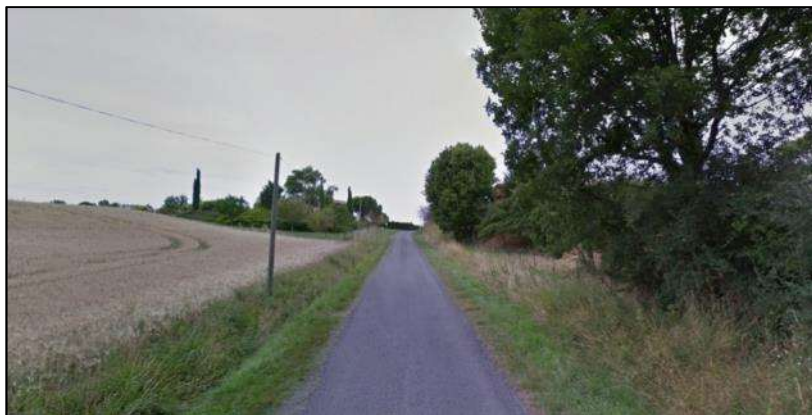
4. Entrée Sud par une route communale Source :Google Street
