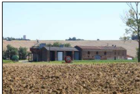
« Labau » Source : l'Artifex
