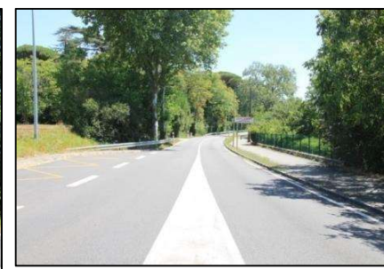
Sortie Est par la RD 1
