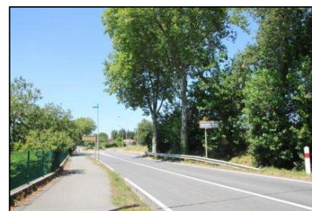
Entrée Est par la RD 1
