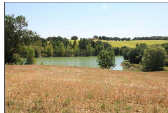
La retenue d'eau « les Andrès » Source : l'Artifex
