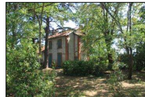
L'ancienne gare face à la Mairie
