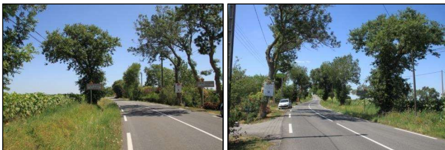
Entrée Ouest par la RD 1
