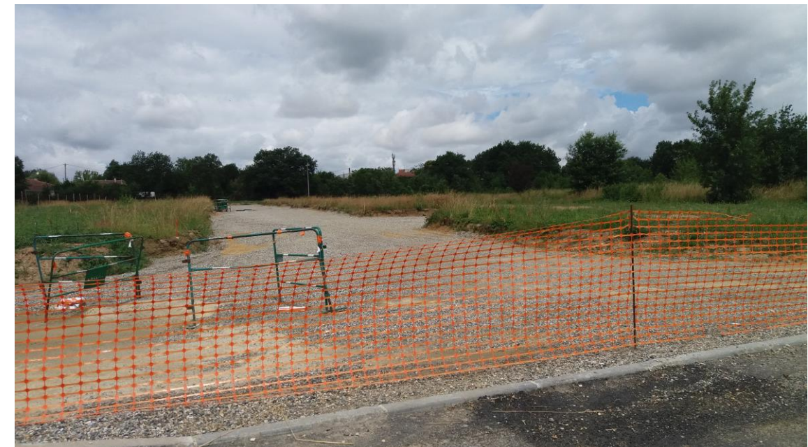
Vue depuis la rue des Erables sur les terrains en cours de viabilisation
