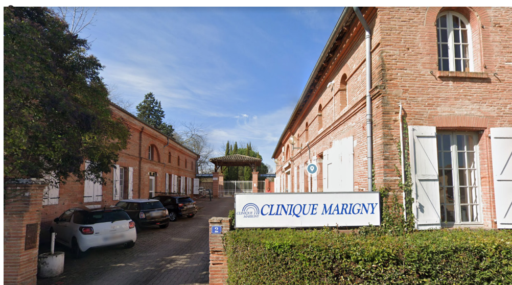
Vue du site depuis la rue du Treil
