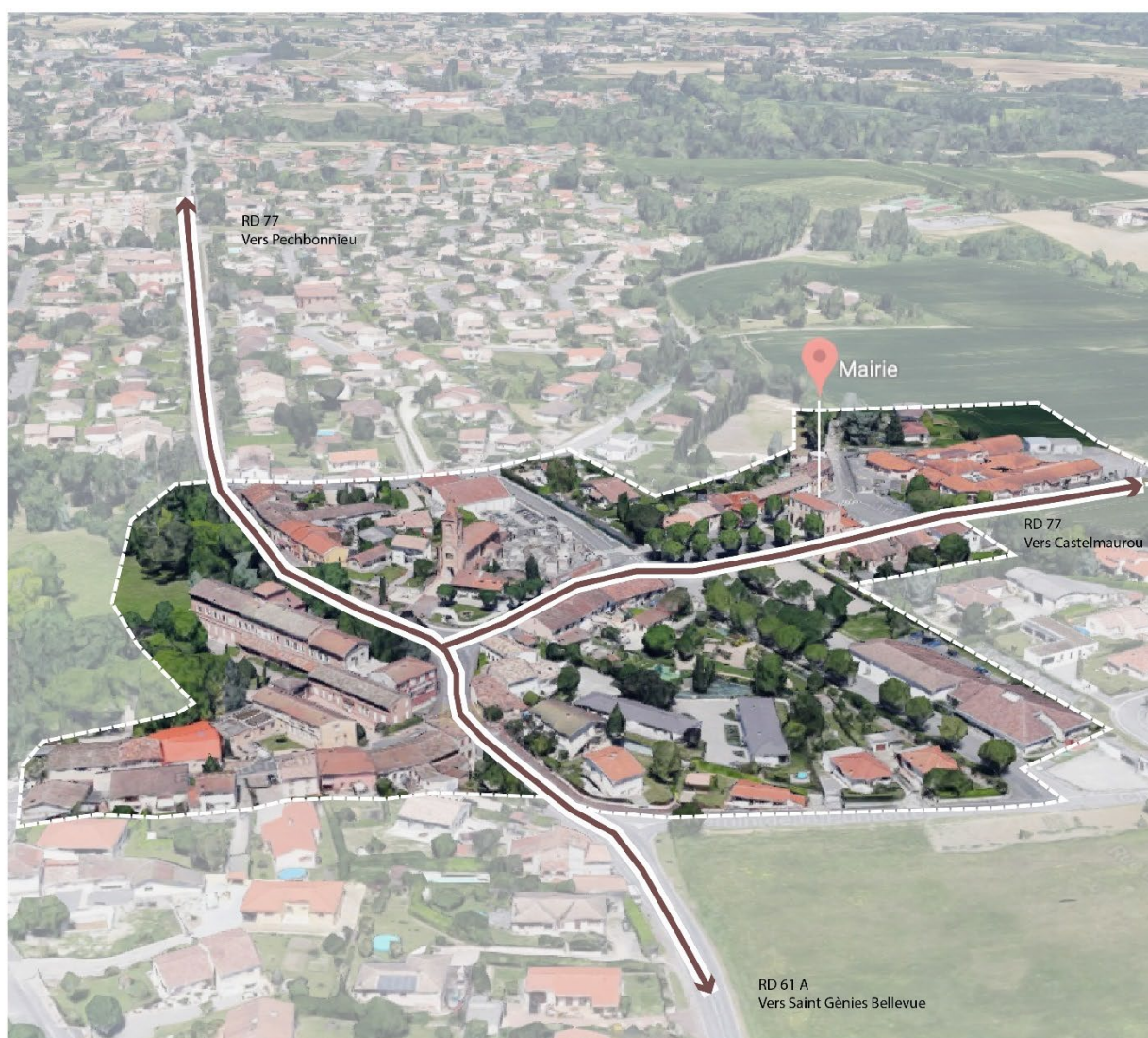
Vue aérienne du centre bourg
