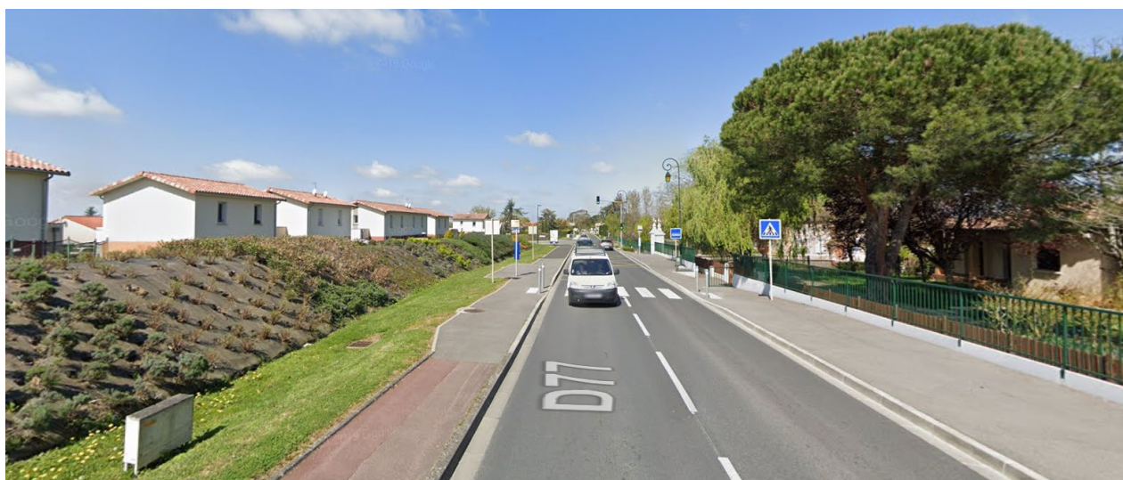
Merlons de terre de l'entrée ouest de la ville (RD77 - route de Pechbonnieu)
