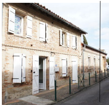
Rue du Treil
