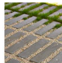
Dalle gazon béton
