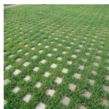
Dalle gazon béton
