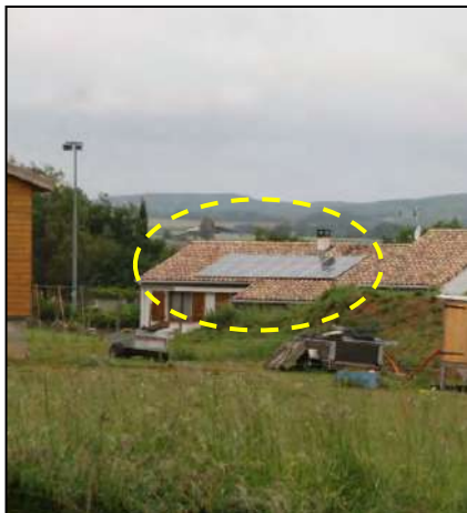
Panneaux photovoltaïques sur toiture
