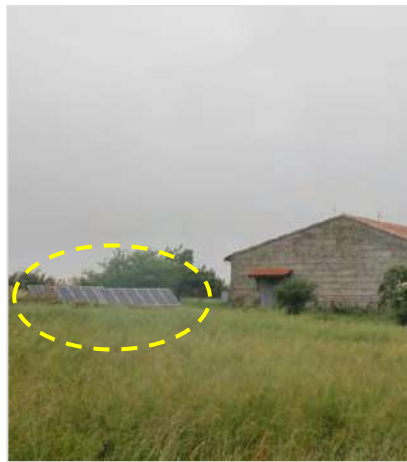
Panneaux photovoltaïques au sol
