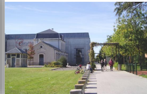
Espace Eurythmie + coulée verte (Montauban)
