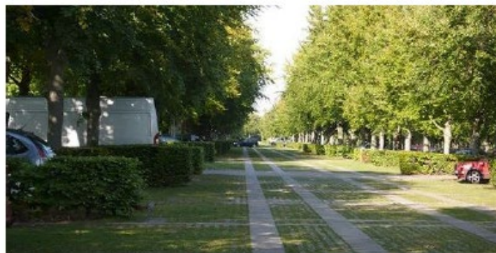
Exemple d'espaces de stationnement non imperméabilisés
