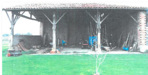
1 – Bâtiment à La Carretère
