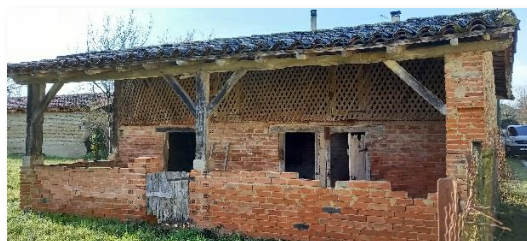
9 – Ancienne porcherie rue de la chapelle
