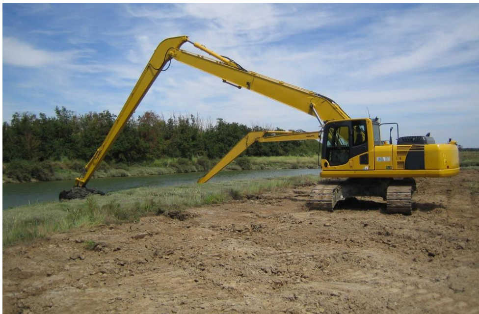
Figure 83 - Exemple de mise en situation pour le curage d'une retenue (Soerma TP)
