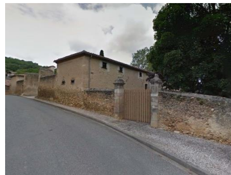
Le Château de Saint Michel est dissimulé derrière un grand mur d'enceinte et de grands arbres (1)
