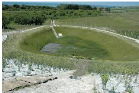
Bassin de rétention
