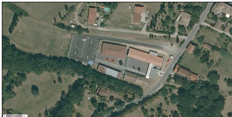
Stationnements matérialisés à proximité de l'école
