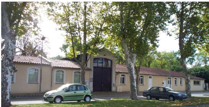
Le groupe scolaire récemment réhabilité
