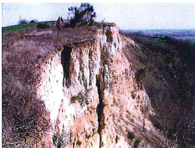
Falaises actives (écaill instables), cirque des « Clotes » Commune de Cintegabelle
