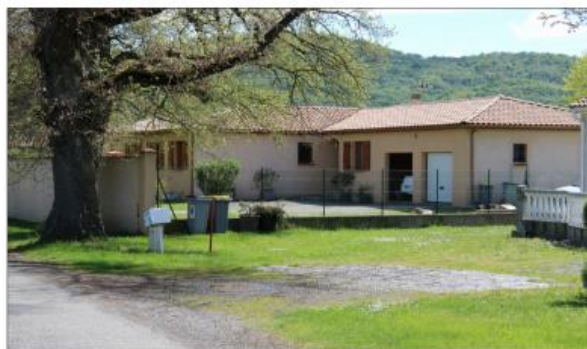
Lieu-dit «Loumagne», lisière urbaine de Martres-T.
