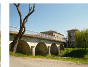
Franchissement de l'Arbas
