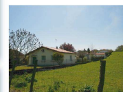
Quartier pavillonnaire vu depuis la RD117
