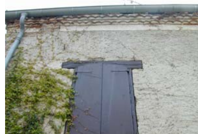
Génoises à Saint-Pé d'Ardet
