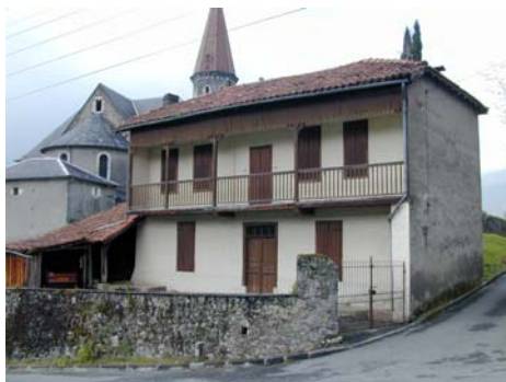
Enduit et bandeau en badigeon plus clair à Génos, façade sur rue à Génos, façade d'une maison sur cour à Ore
