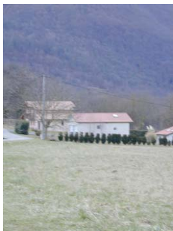
Constructions entre Lourde et Mont-de-Galié, à Lourde, entre Lourde et Ore.
