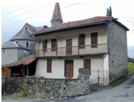
Enduit et bandeau en badigeon plus clair à Génos, façade sur rue à Génos, façade d'une maison sur cour à Ore
