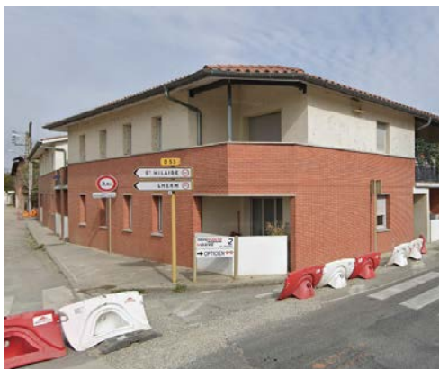
Logements collectifs, Rue de l'industrie, Lavernose-Lacasse
