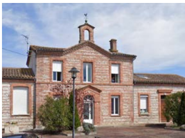
Ancien château de Lacasse réhabilité en logements collectifs
