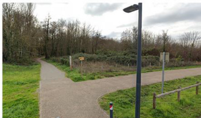
Passage d'une voie cyclable au cœur d'une trame verte et bleue (Portet-sur-Garonne)
