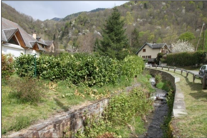
Figure 70 : Ruisseau de Salens canalisé dans le centre bourg
