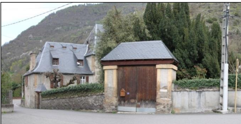
Maison bourgeoise, « château »- toiture en ardoise, Place de l'Ormeau, Source : L'Artifex
