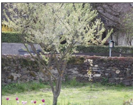
Figure 90 : Murets de pierre sèche, source : L'artifex
