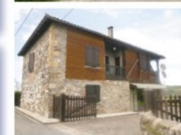
Bâti ancien rénové
