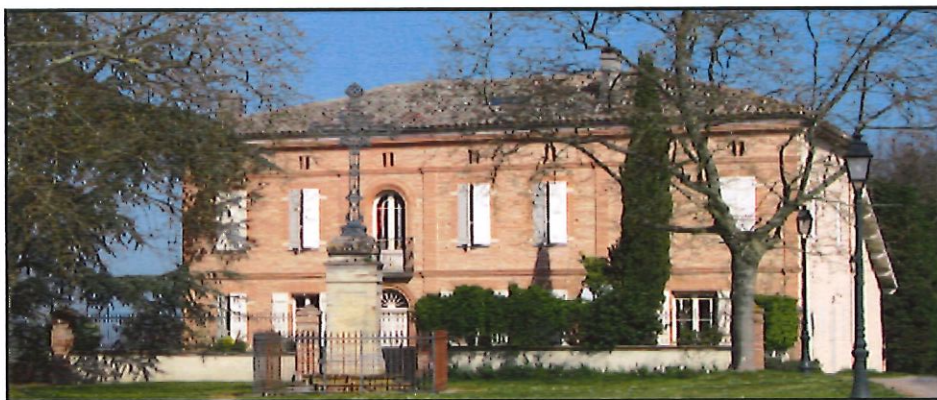
Construction en terre cuite – Source : Agence Jean Gaichies
