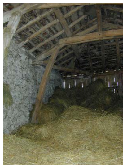
Annexe et effet de lambrequins de bois découpé en planche de rive à Galié, débords de toiture et versants pour cette grange à Mont-de-Galié, Abri à cochon à Saint-Pé d'Ardet "corniche" en lauze pour cette grange au Vignaut (Malvezie) charpente de grange à Mont-de-Galié.
