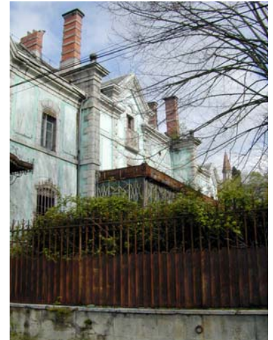
Deux exemples de cette variété, situés tous deux en limite des villages : - à Ore l'ensemble aujourd'hui désaffecté des "œuvres laïques" algériennes, dont les bâtiments, parc et dépendances sont d'un grand intérêt et témoignent d'un programme ambitieux - à Malvezie villa plus modeste.
