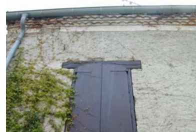
Génoises à Saint-Pé d'Ardet
