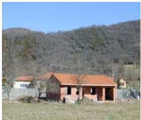
Construction à Malvezie à l'entrée Ouest du village
