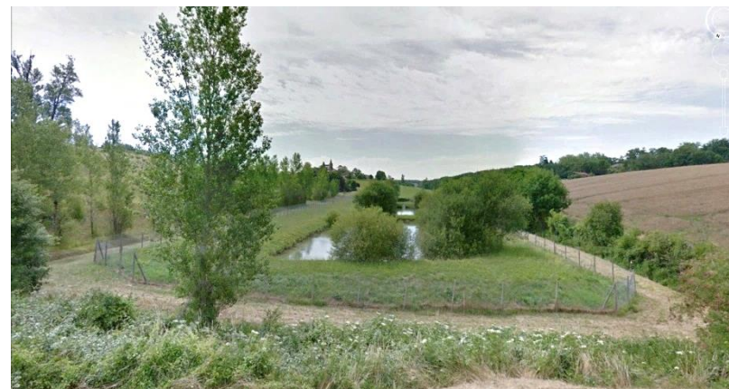
Vue depuis le chemin de Al Batut sur la station d'épuration, en direction du clocher de l'église St Julien.
