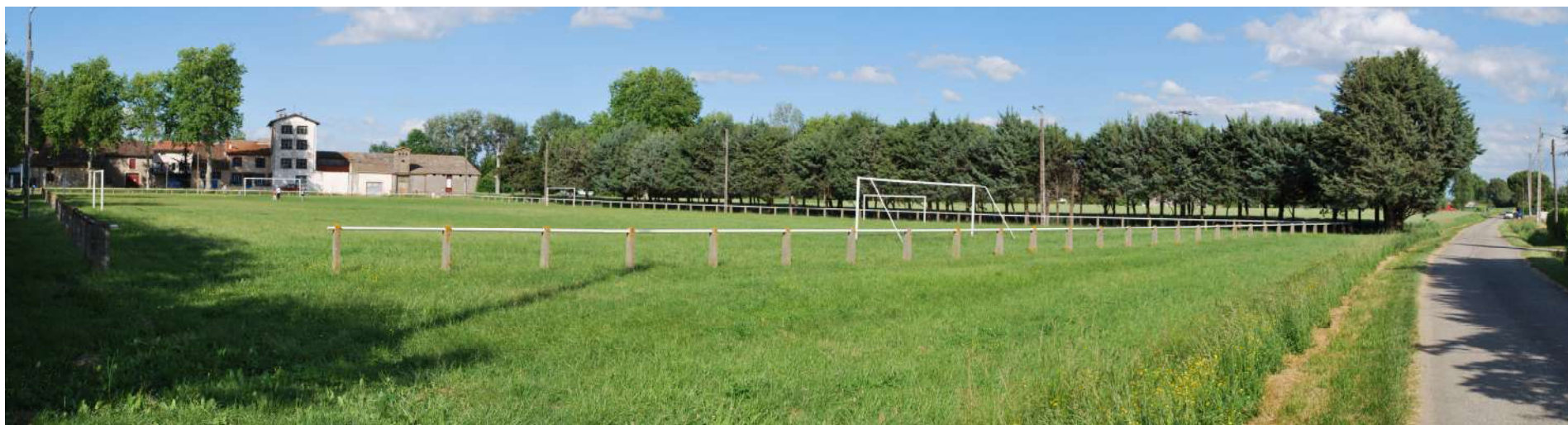
Panorama depuis l'angle sud ouest du site. A gauche en arrière plan, la minoterie prolonge la ligne créée par l'alignement de platanes. L'alignement protégeant le terrain n'est pas emblématique et reste artificiel. Aussi il sera sans doute nécessaire de le supprimer ou du moins de l'éclaircir.
