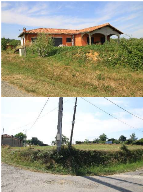
Figure 7 : Habitation en cours de construction au Cap du Tes-est et prairie pâturée, enjeu de conservation écologique faible (parcelles constructibles B380, B381 et B382).
