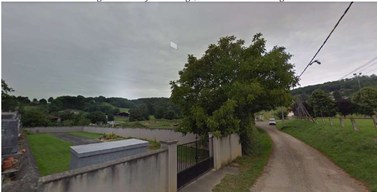
Figure 18 : parcelle A1054, attenance à l'extension du cimetière, constructible à vocation d'activité (Source : Google Street View)
