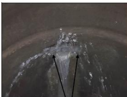
2 infiltrations au niveau de l'arrivée de la conduite depuis R131,1
