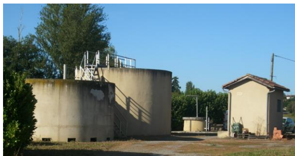
Station d'épuration existante du Fousseret
