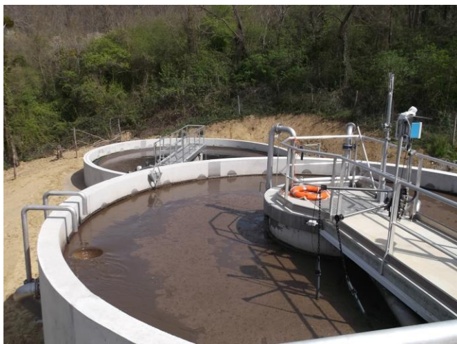
Station d'épuration de Mauzac (capacité 1 800 équivalent habitant)
