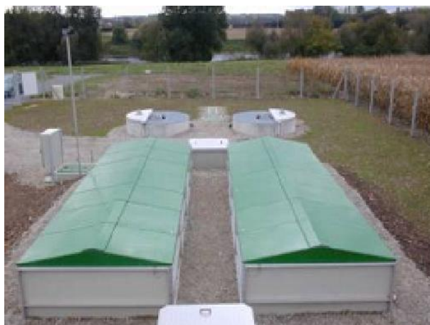
FIGURE 8 : TRAITEMENT BIOLOGIQUE DES EAUX PAR BIODISQUES SUR 2 FILES
