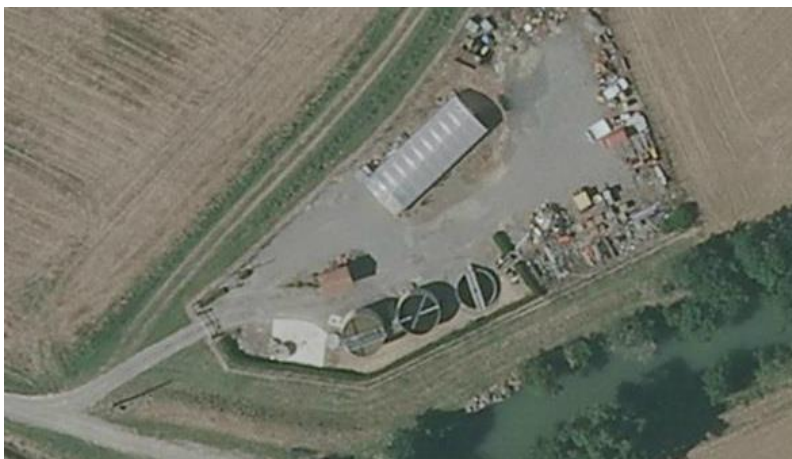
FIGURE 7 : VUE AERIENNE DE LA STATION D'ÉPURATION
