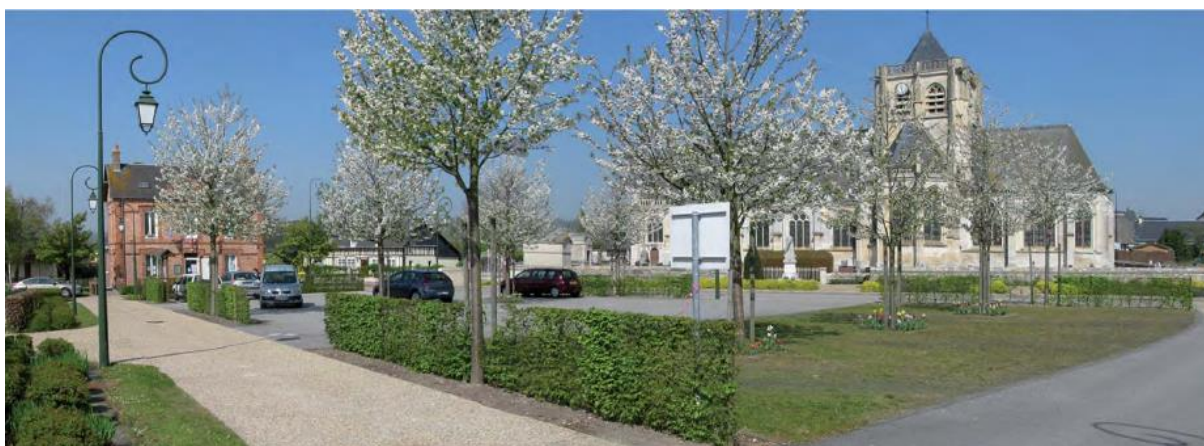
Espace de stationnement à Vatteville-la-rue (27) : le stationnement régulier se fait sur de l'enrobé, l'occasionnel sur des surfaces engazonnées
