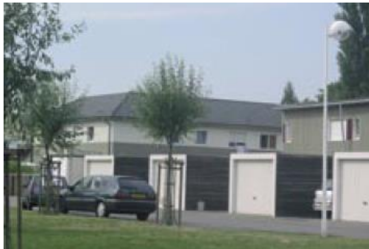
Type de stationnement à éviter dans les secteurs d'habitat groupé : garages individuels alignés le long de la rue
