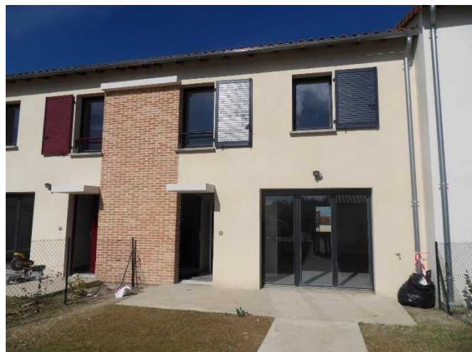
Exemple de façade avec utilisation de la brique sur la première phase de Carbonade
