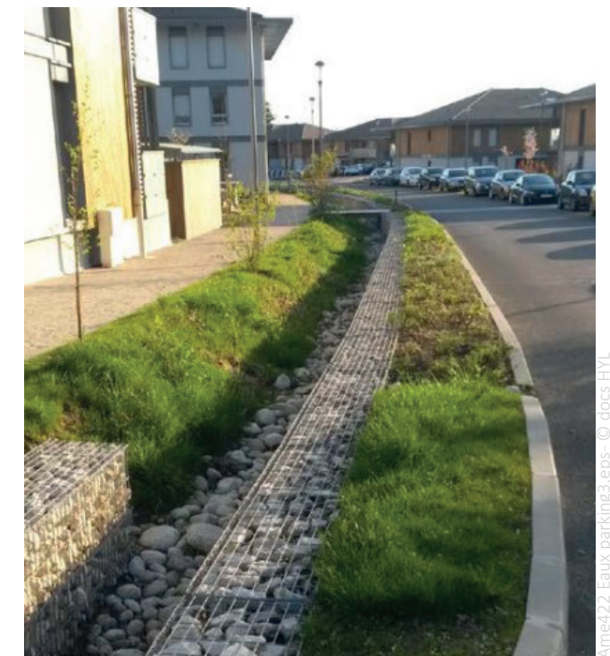
Exemple de tranchée d'infiltration
