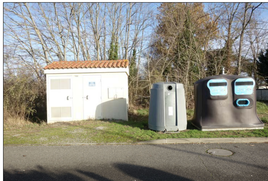
Vue vers le Nord depuis la rue des Pyrénées
