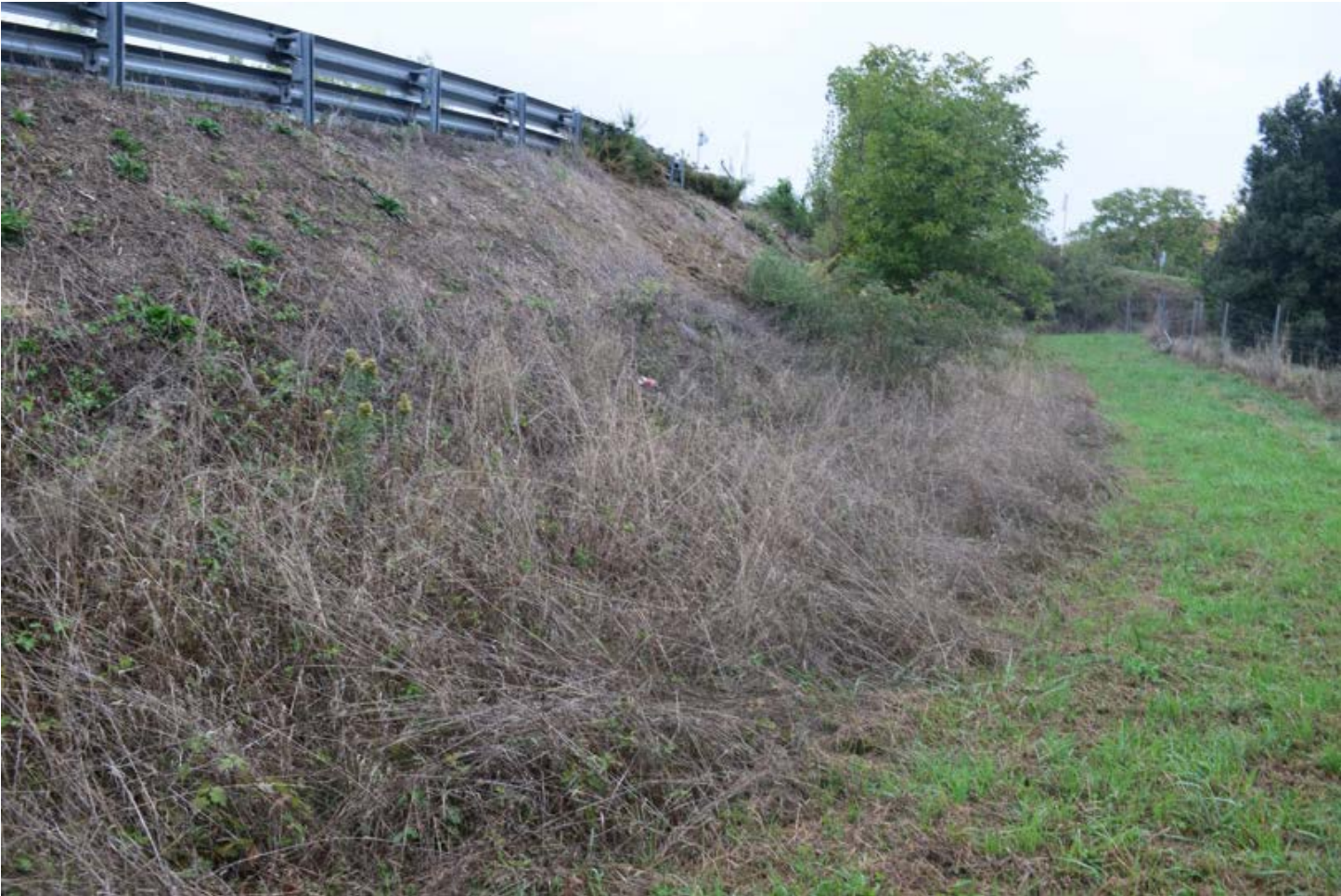
Figure 5 : Talus et remblais en marge Nord de la zone de projet (photographie prise le 06 octobre 2022)
