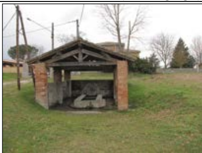
L'ancien lavoir (source : wikipédia)
