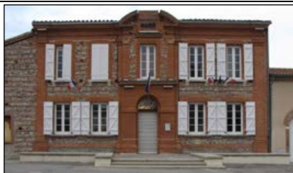
La mairie (source : wikipédia)
