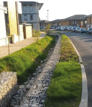
Exemple de tranchée d'infiltration
