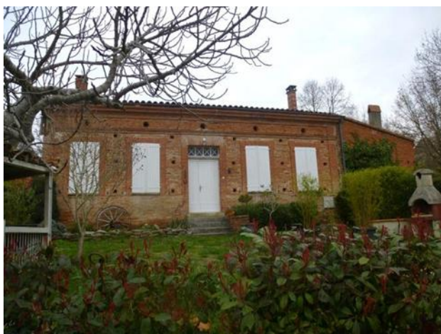
Maison de village d'architecture traditionnelle à préservé Rue Souleilla
