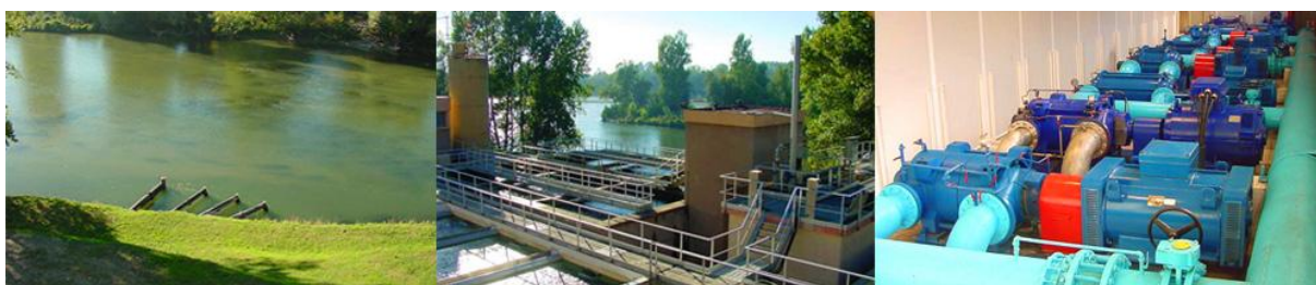
usine PSE – photo Réseau 31
