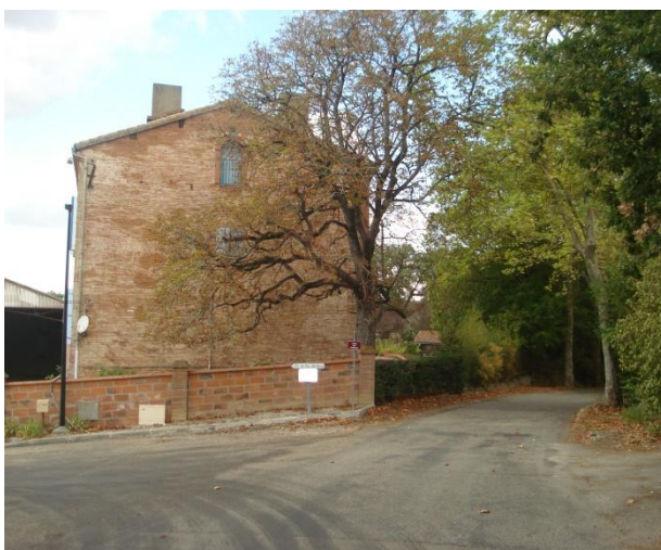
Construction en R+2 : ici l'alignement est marqué par la clôture (matériaux peu qualitatifs)
