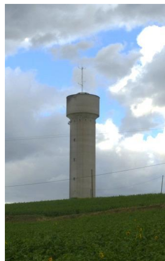
Réservoir dit « d'Espanès »
