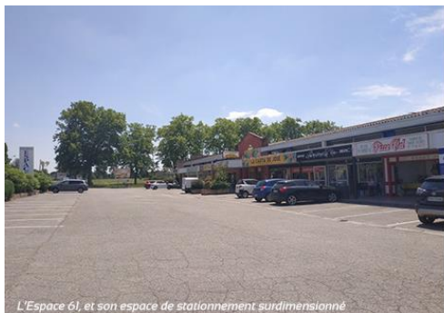
L'Espace 61, et son espace de stationnement surdimensionné
