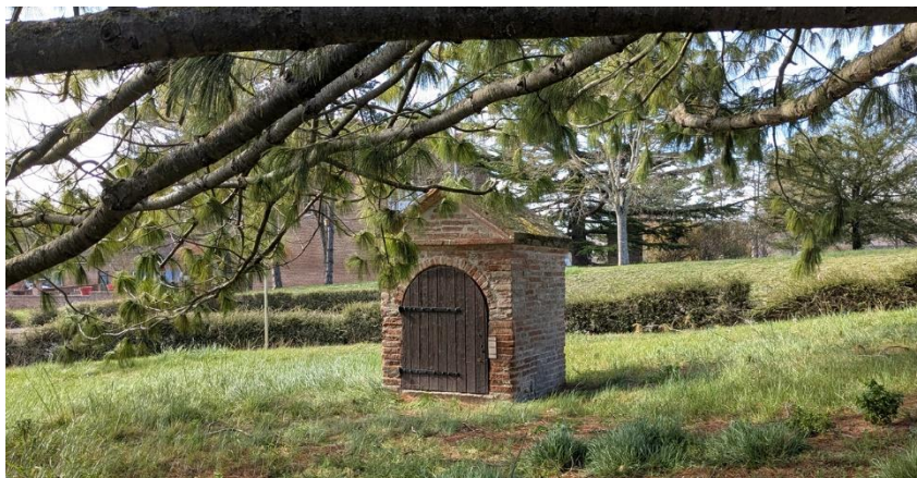
V1-Puit chemin des écoles
