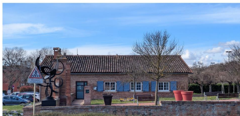
A4-Bâtiments des services techniques
